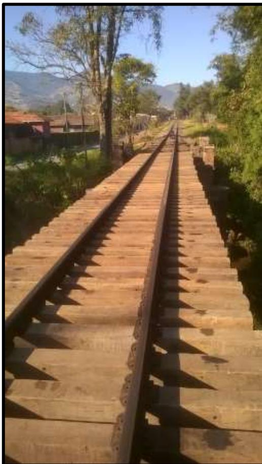
*A ponte já completa, com todos os dormentes novos instalados.*
