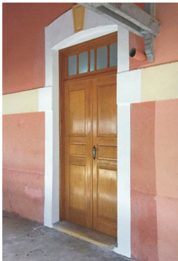
A nova porta instalada na plataforma; como pode ser observado, ela seguiu as medidas encontradas na sobreverga e na soleira, resgatando dessa forma um aspecto mais próximo do original e melhorando de sobremaneira a harmonia dos vãos da edificação (esquerda); Nova porta instalada no saguão da estação para acesso à bilheteria; pode-se observar que o revestimento cerâmico descaracterizante foi removido.
