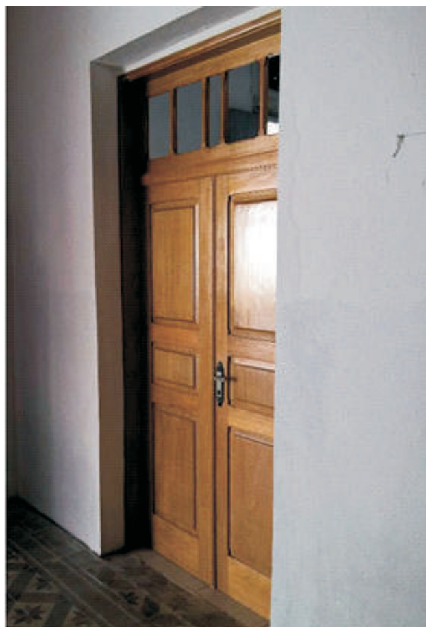
A nova porta instalada na plataforma; como pode ser observado, ela seguiu as medidas encontradas na sobreverga e na soleira, resgatando dessa forma um aspecto mais próximo do original e melhorando de sobremaneira a harmonia dos vãos da edificação (esquerda); Nova porta instalada no saguão da estação para acesso à bilheteria; pode-se observar que o revestimento cerâmico descaracterizante foi removido.
