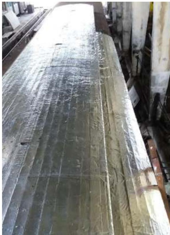
*À direita: Manta asfáltica com cobertura de alumínio sendo colocada no O3, em nossa sede*
