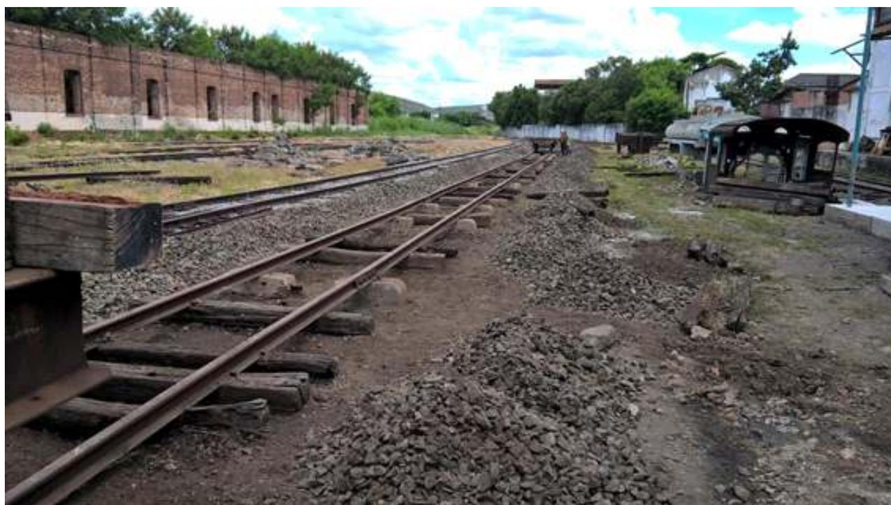
*Manutenção em mais uma via do pátio da estação de Cruzeiro; dormentes sendo substituídos e descontaminação do lastro*
