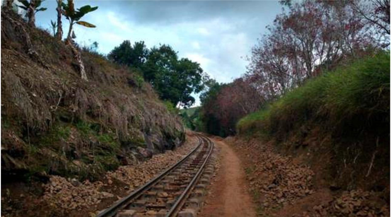
*Manutenção da via permanente no km89+100: remoção e descontaminação do lastro antigo, substituição de todos os dormentes por de concreto, correção da geometria da via para posterior reaplicação do lastro descontaminado aliada a complementação com novo.*
