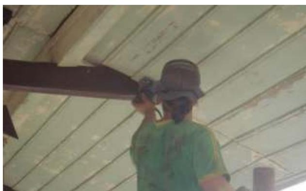
*Retirada do excesso de tinta da plataforma*
