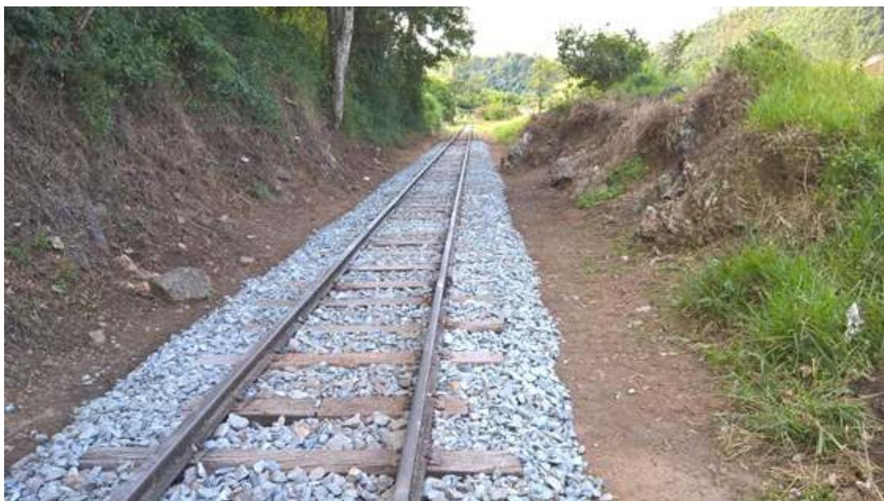
*Reta do km 31+300: o lastro antigo foi descontaminado, os dormentes foram substituídos, a geometria da via corrigida e o lastro foi complementado com novo*
