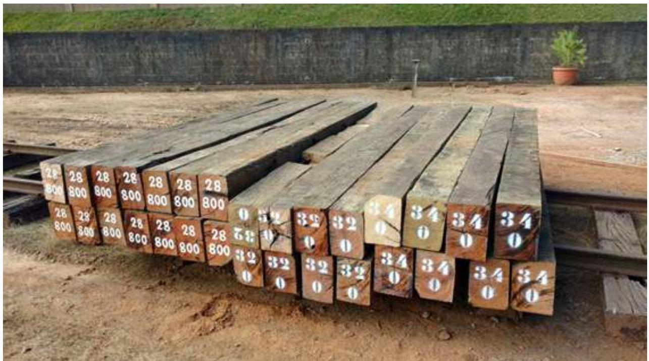
*Dormentes preparados na marcenaria de São Lourenço para instalação nas pontes do trecho do Trem da Serra da Mantiqueira; as marcações são referência para instalação dos mesmos, uma vez que os entalhes são diferenciados conforme a estrutura das pontes*
