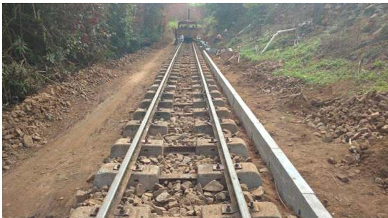
*Manutenção da via permanente no km88+000: preparação e instalação do para-lastro*
