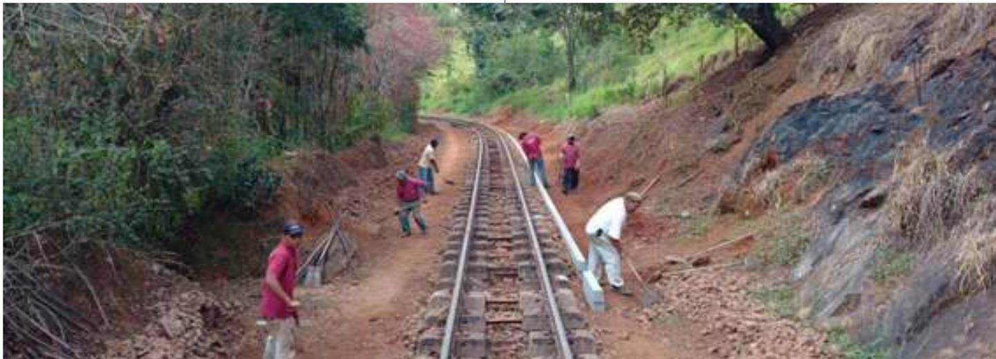
*Manutenção da via permanente no km 88+000: remoção e descontaminação do lastro antigo, substituição de todos os dormentes por de concreto, correção da geometria da via*
