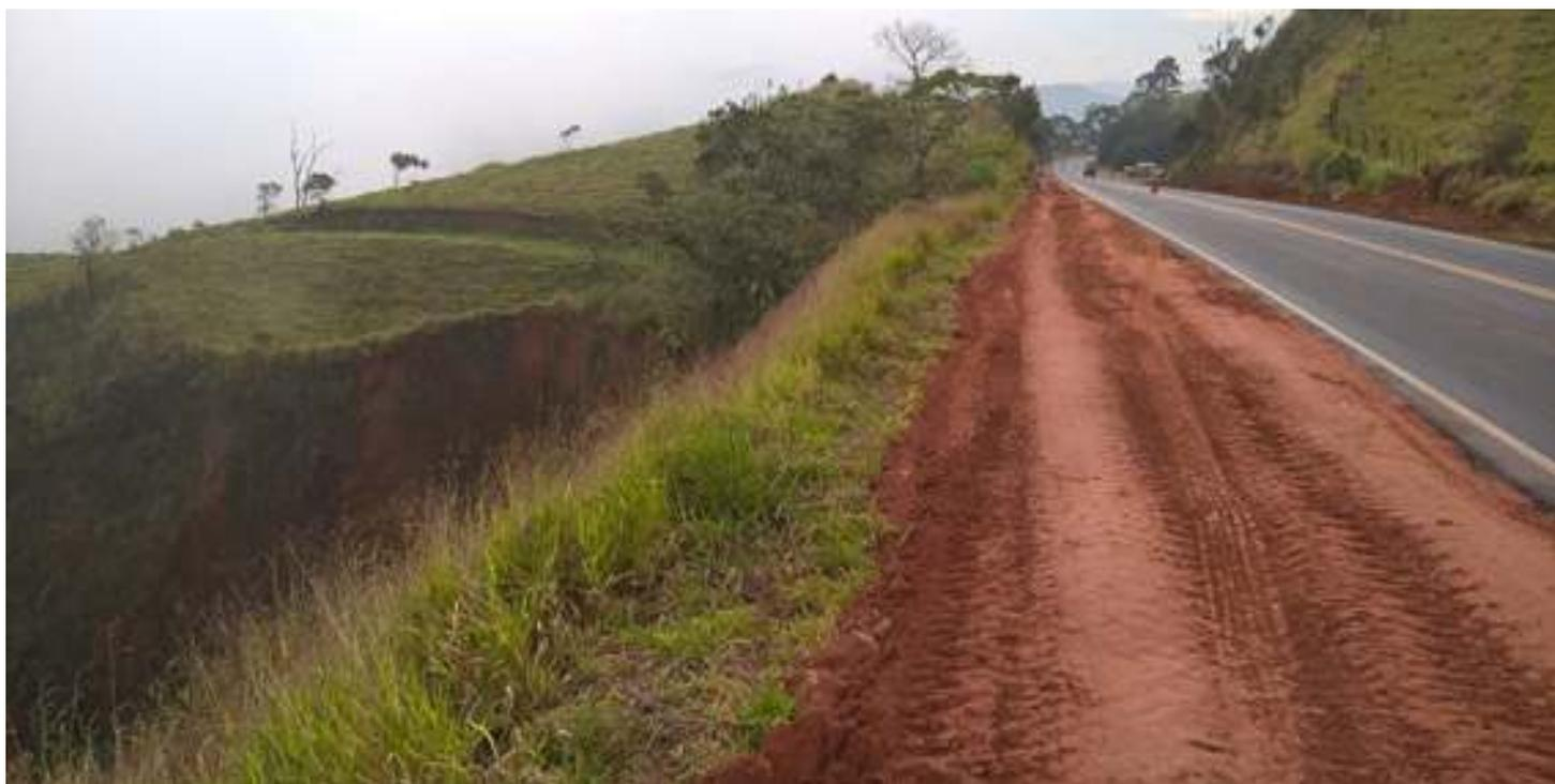
*Obras na rodovia com modificação do sistema de drenagem afim de se evitar o derramamento de água na ferrovia que fica logo abaixo*
