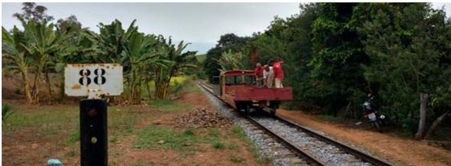
*Manutenção da via permanente no km88+000: aplicação de lastro*
