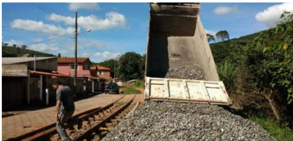
*O novo lastro sendo descarregado ao lado da via para posterior aplicação pela equipe de via-permanente*
