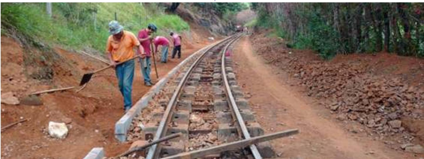
*Manutenção da via permanente no km88+100: remoção e descontaminação do lastro antigo, substituição de todos os dormentes por de concreto, correção da geometria da via e instalação de para-lastro para posterior reaplicação do lastro descontaminado aliada a complementação com novo.*
