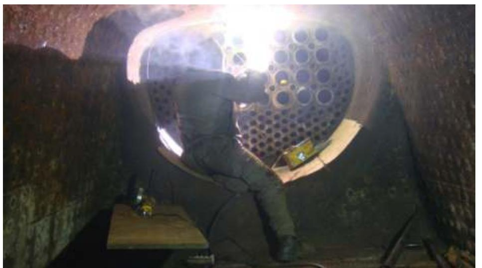
*A soldagem dos tubos no espelho no lado da fornalha*
