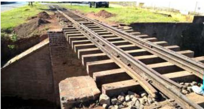
*Ponte do Km32+950 com os novos dormentes já instalados*
