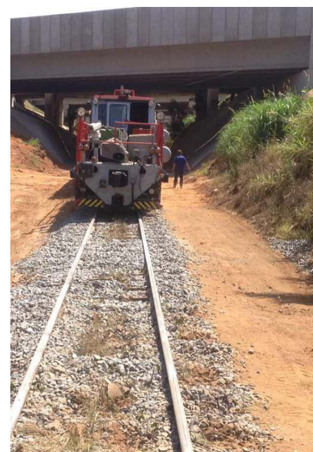
A máquina reguladora em operação no trecho próximo à estação de Anhumas.
