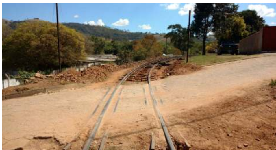
PN do km 83+200 antes do início dos trabalhos
