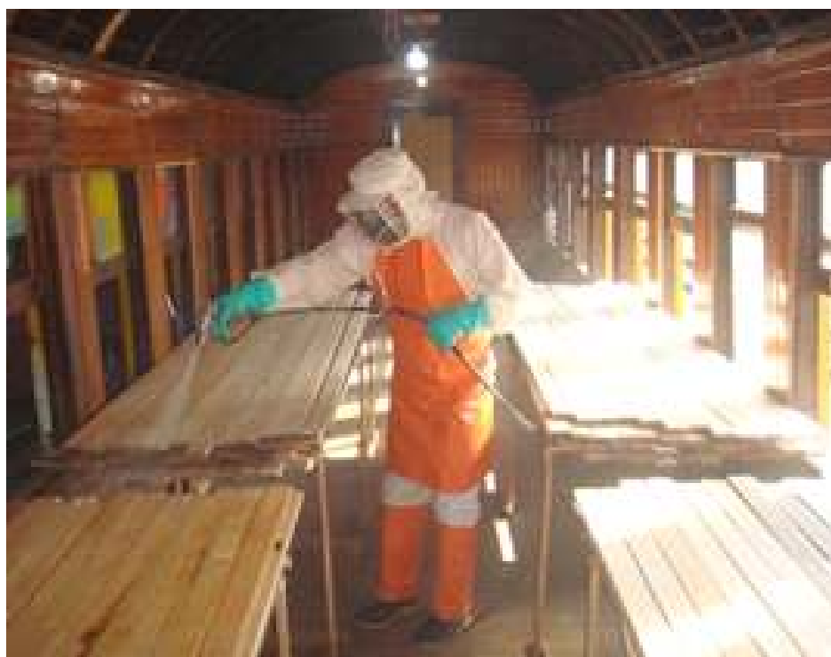
Aplicação de inseticida de anticupim no novo forro
