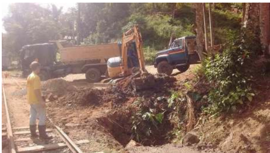
Tubos já colocados ao longo da via férrea (foto de Otávio Georg Junior)
