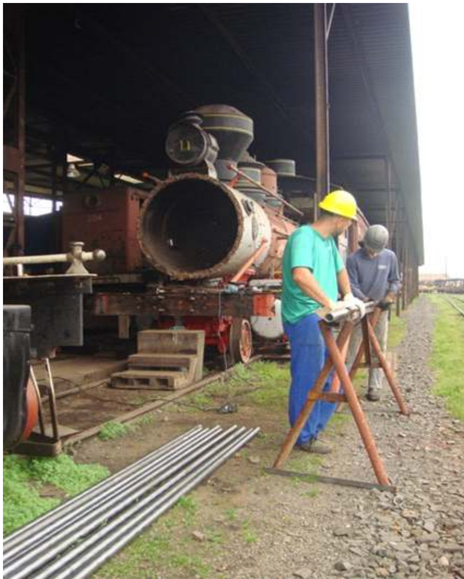
Preparação de tubos para instalação
