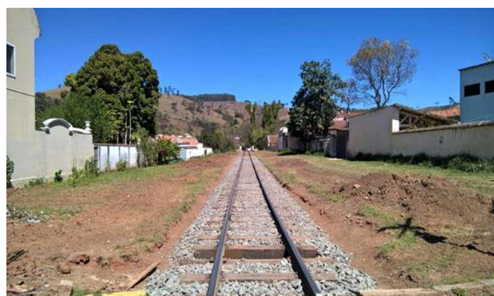
Manutenção da via permanente no km34+300: remoção e descontaminação do lastro antigo, substituição de todos os dormentes, correção da geometria da via, além da limpeza completa no entrono da via
