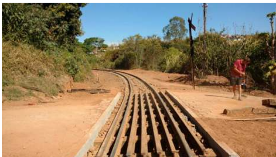
PN do km 83+200 já com os dormentes substituídos, novos contra-trilhos e para-lastro instalado
