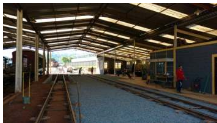
Brita já espelhada no chão da oficina para receber o concreto
