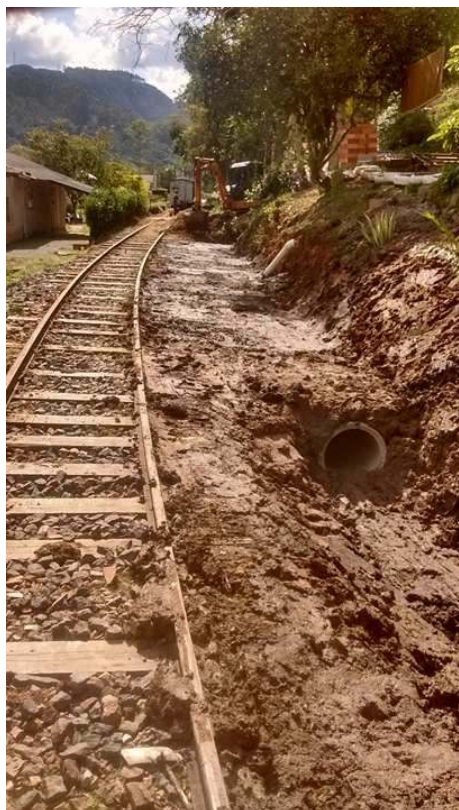
Trabalhos de preparação para canalização da rede pluvial e esgoto (foto: Otávio Georg Junior)
