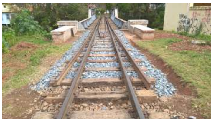
Manutenção da via permanente no km34+300: remoção e descontaminação do lastro antigo, substituição de todos os dormentes, correção da geometria da via, além da limpeza completa no entrono da via
