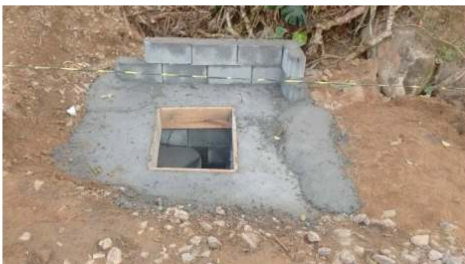
Coletor da rede de esgoto em fase de construção (foto: Otávio Georg Jr)
