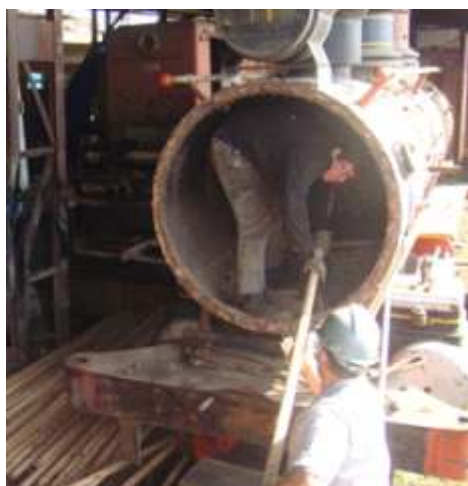
Retirada dos tubos
