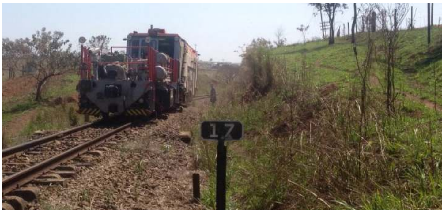
A moderna máquina de via permanente da Engecom em plena operação no km 17 da VFCJ
