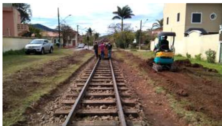
Manutenção da via permanente no km34+300: remoção e descontaminação do lastro antigo, substituição de todos os dormentes, correção da geometria da via, além da limpeza completa no entrono da via
