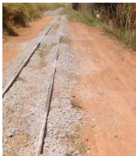
Trecho da via em dandamento e treecho já pronto
