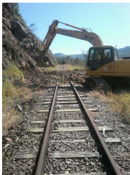
Finalização da limpeza sobre a via permanente, assim que a máquina deixou o local, os serviços de recuperação iniciaram.
