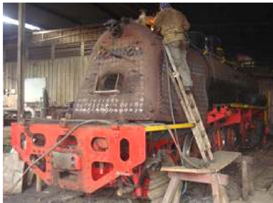
Trabalhos na fornalha da locomotiva Mikado nº 4
