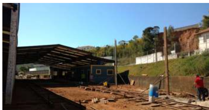
Trabalhos de ampliação do galpão da oficina de São Lourenço: mais dois módulos serão acrescentados afim de aumentar a capacidade do mesmo
