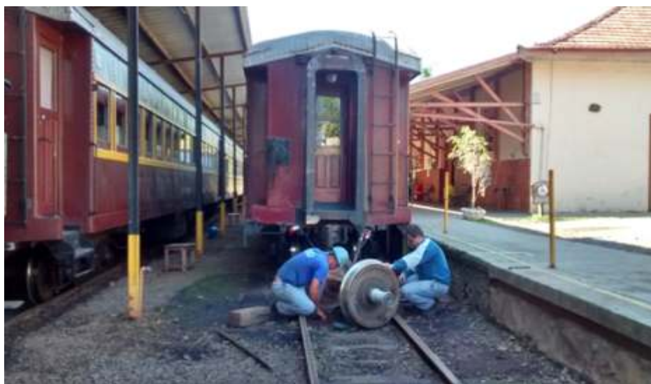
Preparação para encarrilhar o rodeiro e iniciar a substituição
