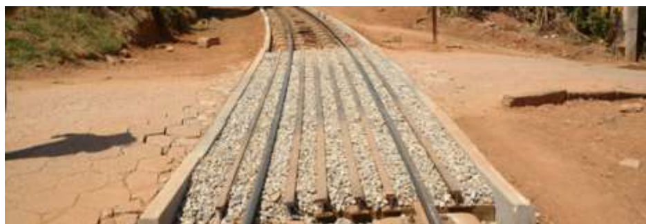
PN do km 83+200 após a conclusão dos trabalhos
