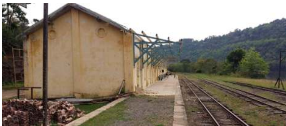
Início dos trabalhos de remoção do telhado e reconstrução da estrutura.
