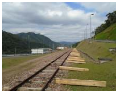
Dormentes já dispostos ao longo da linha para a substituição (foto de Luiz Carlos Henkels)
