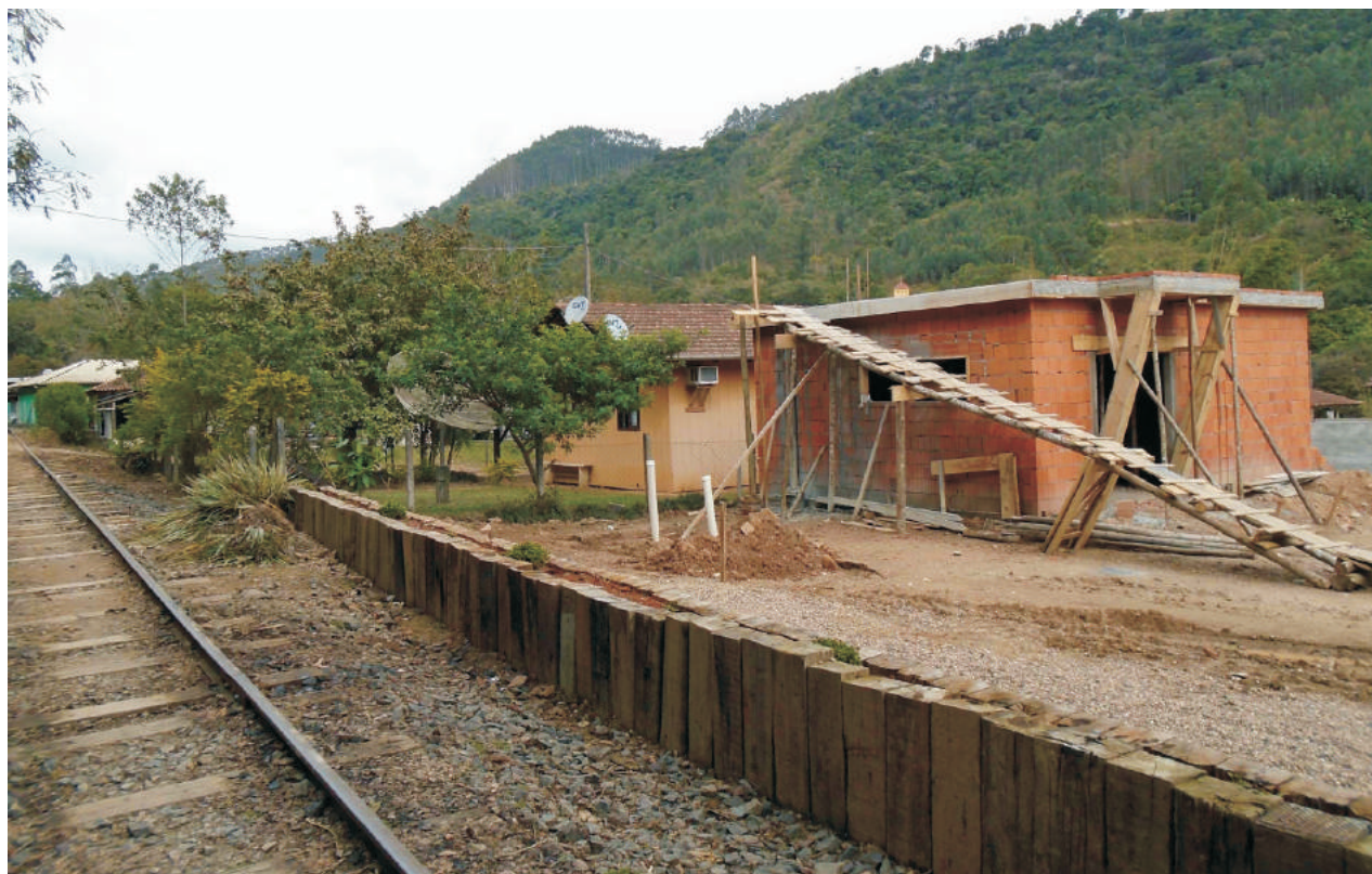
Fase inicial da construção do prédio que abrigará os sanitários. Foto de Luiz Carlos Henkels.
