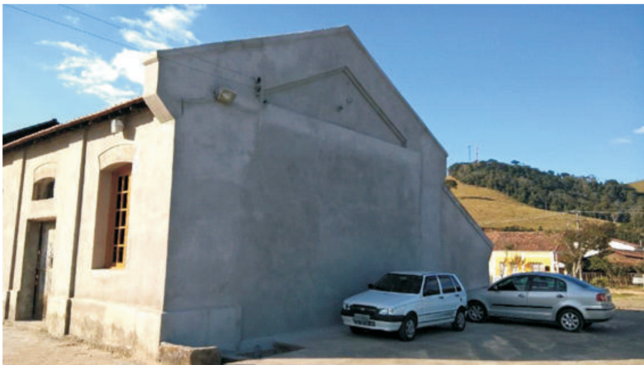
Aspecto da fachada posterior do depósito, já com o novo revestimento aplicado com todos os detalhes mantidos. A fachada frontal ainda não foi trabalhada pois prevê-se a ampliação do depósito para abrigar mais material rodante.
