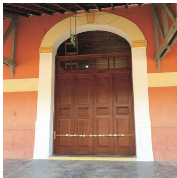
Aspectos das portas já instaladas, acima na fachada frontal da estação e abaixo na posterior. O fechamento da parte superior ainda será instalado
