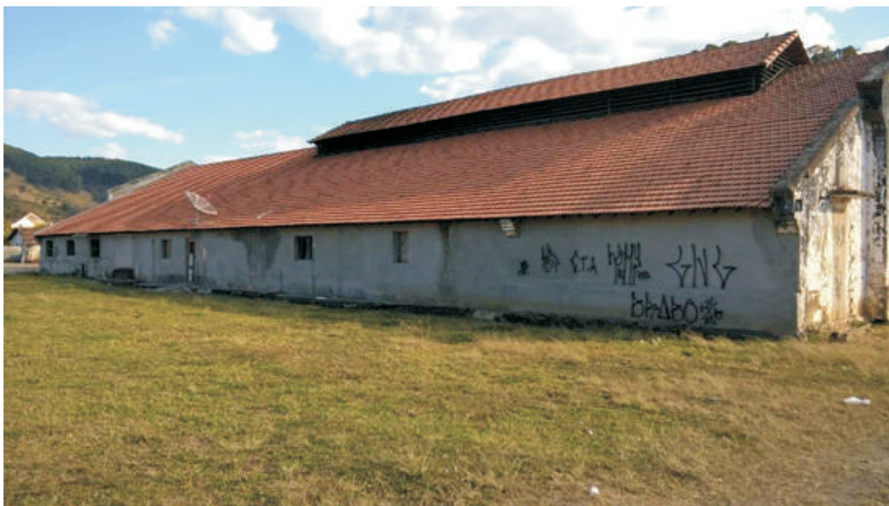
Aspecto da fachada lateral esquerda do depósito, já com o novo revestimento aplicado com todos os detalhes mantidos; infelizmente já sofreu com a ação de vândalos conforme observado nas pichações.
