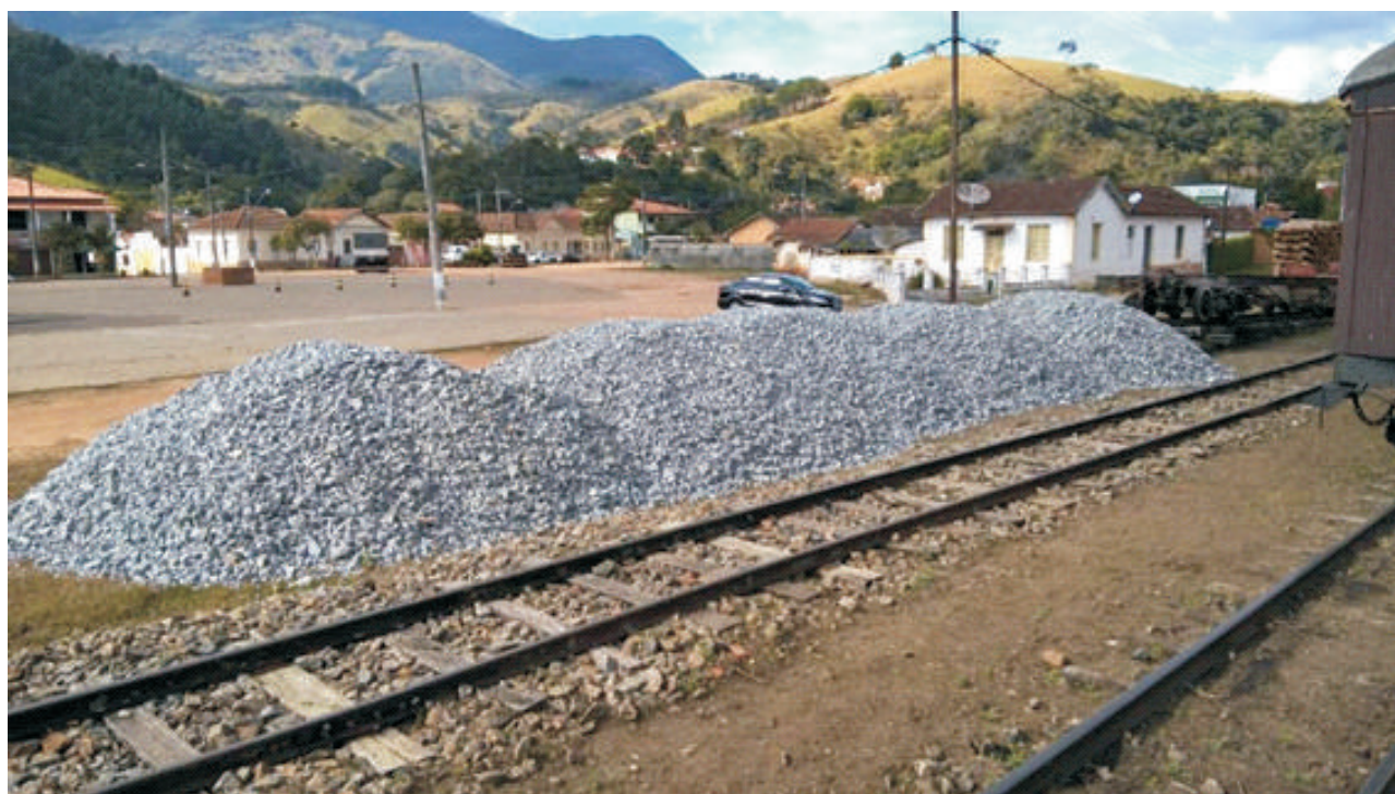
Novo lastro já descarregado no pátio da estação de Passa Quatro
