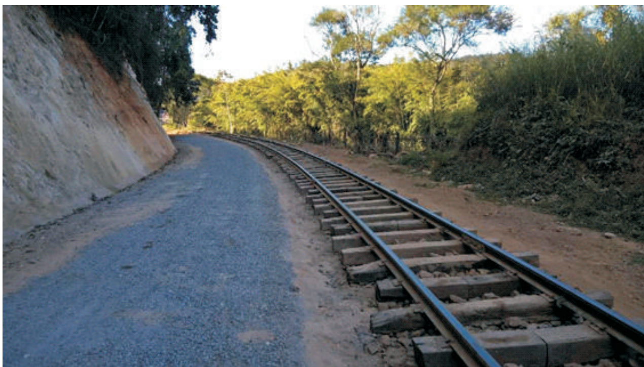
Aspectos da via já com o lastro antigo removido e descontaminado e pronto para ser reaplicado; a grade também recebeu correções em sua geometria.
