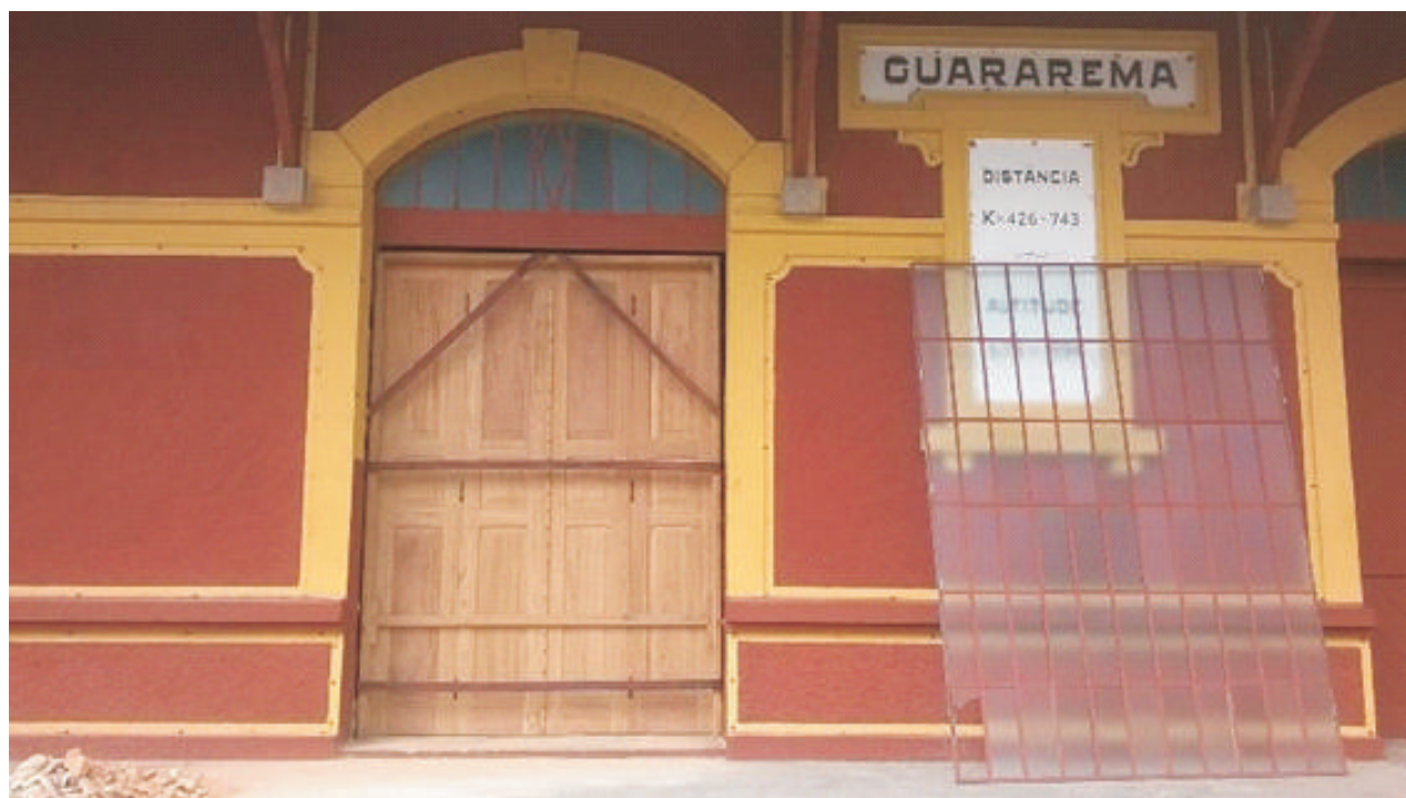
Uma das novas portas de madeira já instalada aguardando os ajustes na estação de Guararema; ao lado, o fechamento de ferro e vidro que havia sido colocado no local anos atrás.
