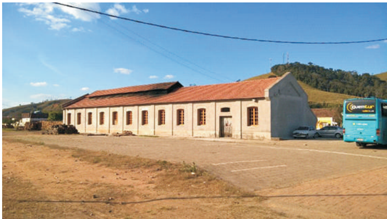
Aspecto da fachada lateral direita do depósito, já com o novo revestimento aplicado com todos os detalhes mantidos; destaque para as novas janelas, feitas na marcenaria de São Lourenço baseadas em uma única original que ainda existia
