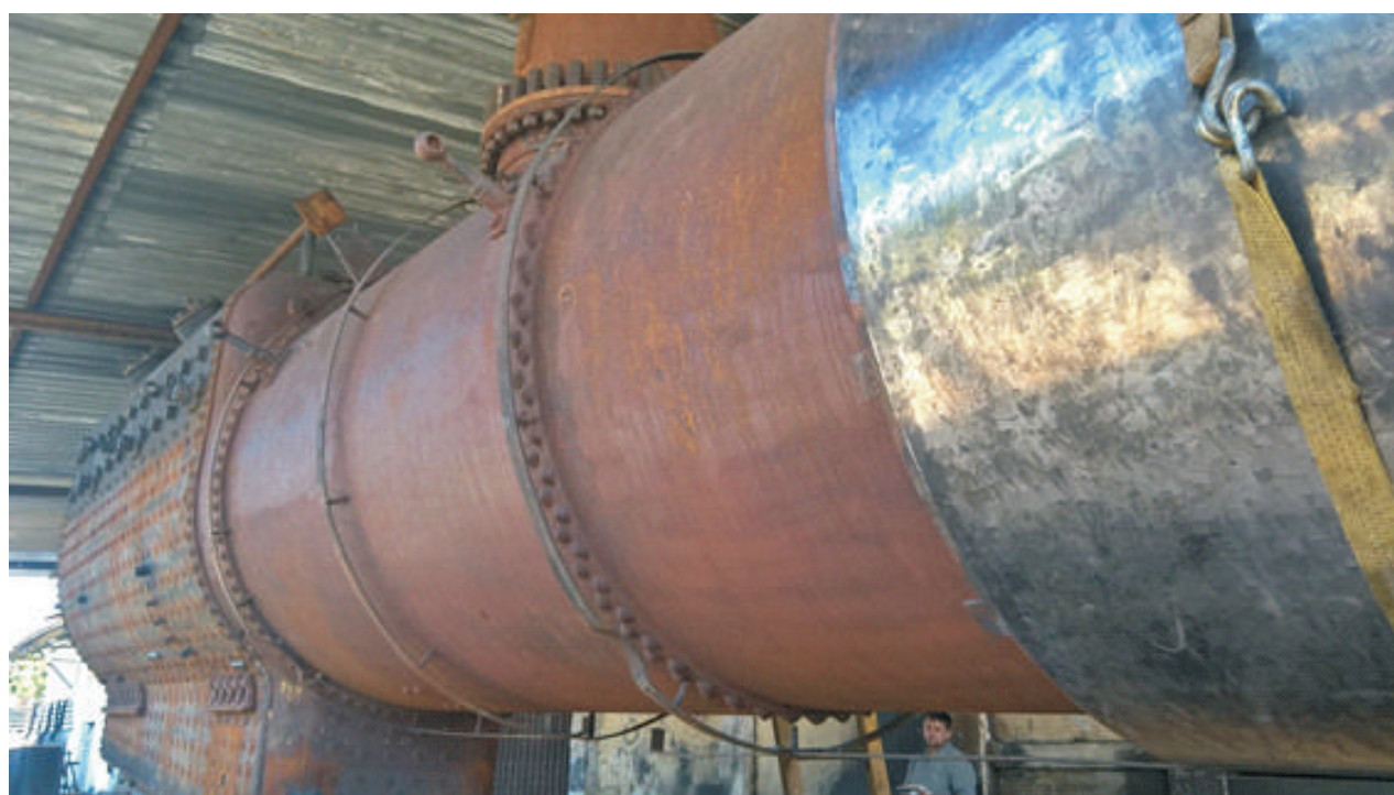
Início da instalação do revestimento na caldeira da locomotiva 327
