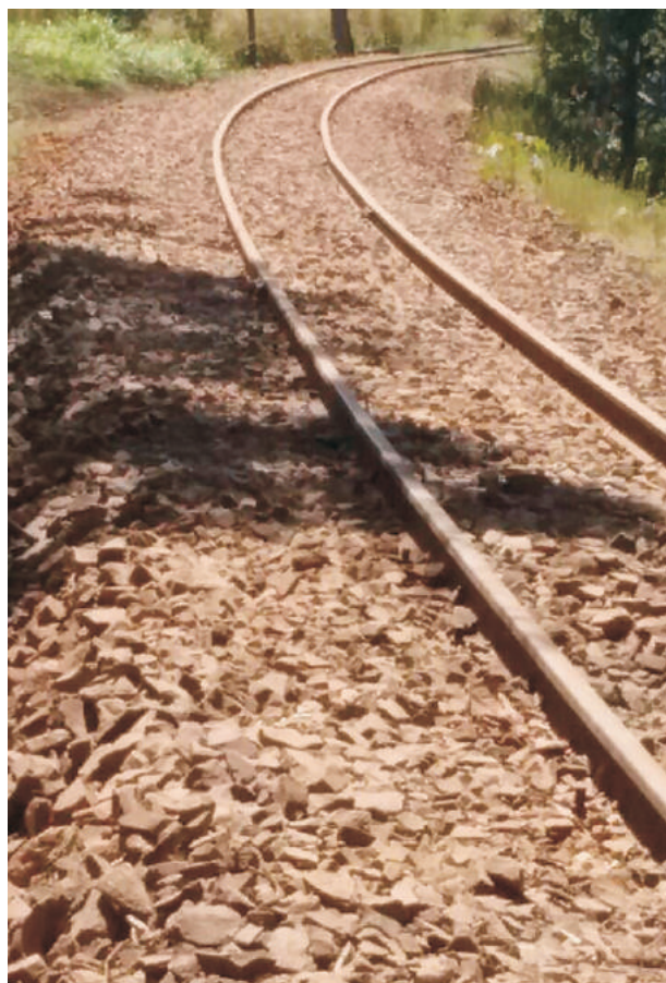
Trecho de via nivelado com os pés de pato
