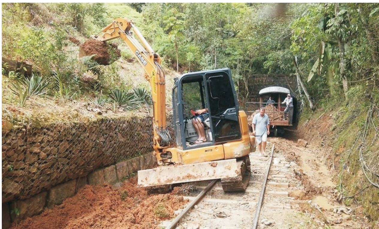
Limpeza de valetas laterais em frente ao túnel da EFSC (autoria de Johnny Sandro Henschel)
