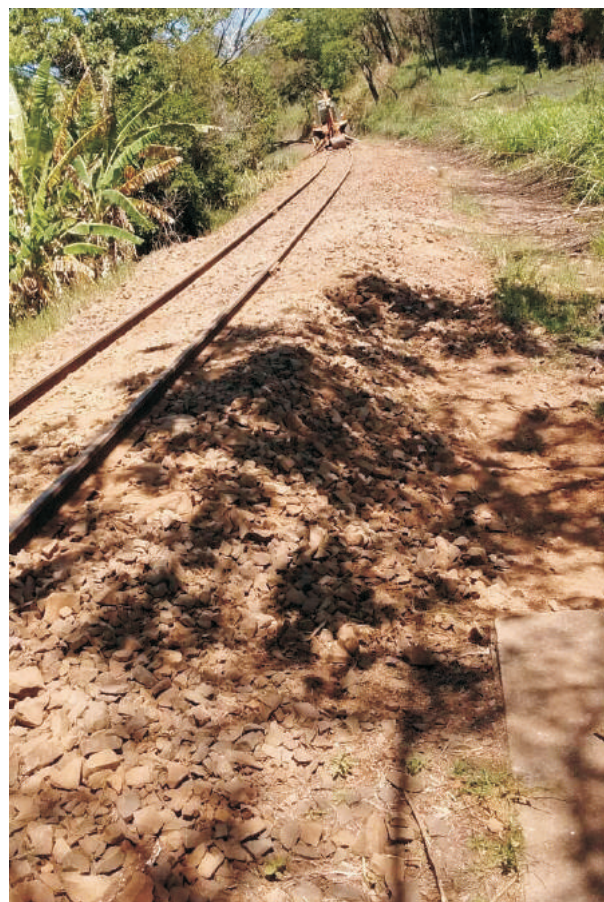
Trecho de via nivelado com os pés de pato
