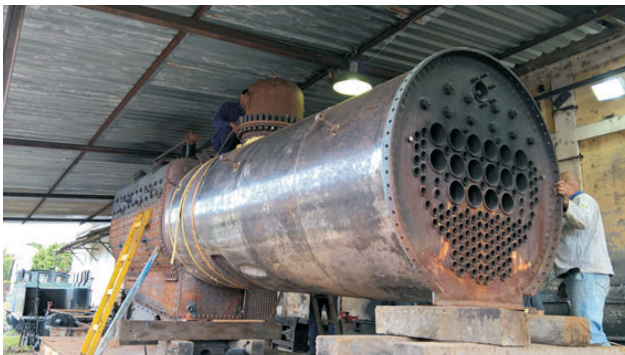
Instalação do revestimento na caldeira da locomotiva 327 já em estágio
