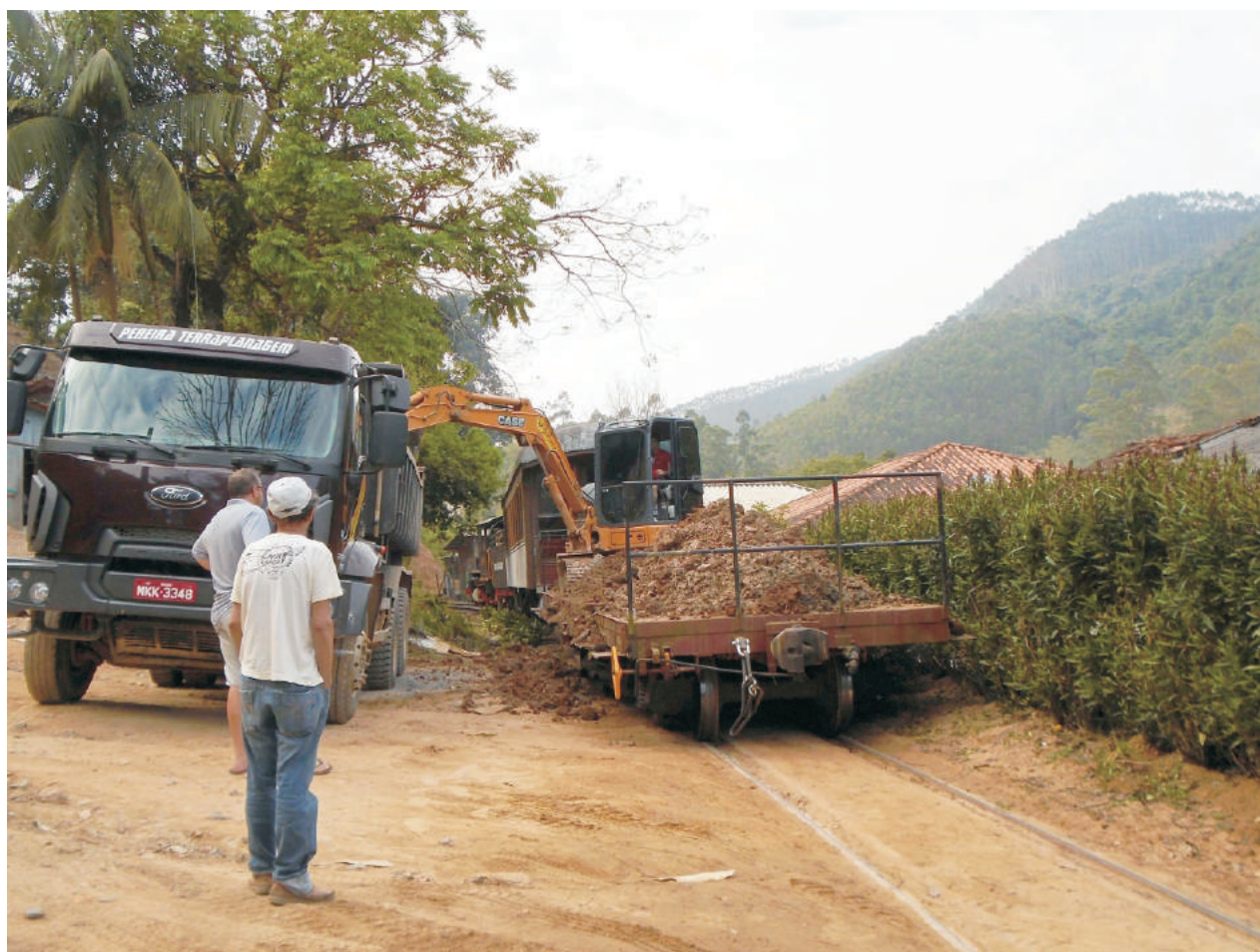
Primeira experiência com escavadeira trabalhando sobre o vagão prancha com resultados muito positivos (autoria de Luiz Carlos Henkels).
