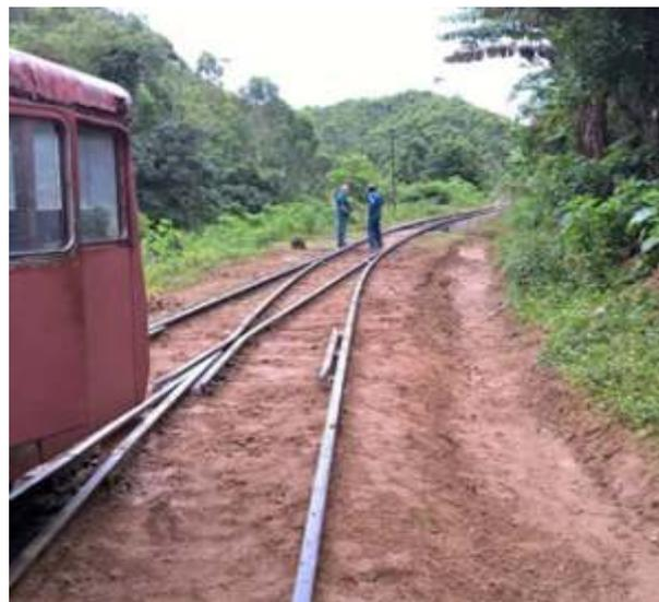
*Abertura de valeta para escoamento de água e substituição de dormentes em Coronel Fulgêncio; a próxima etapa será a descontaminação do lastro*
