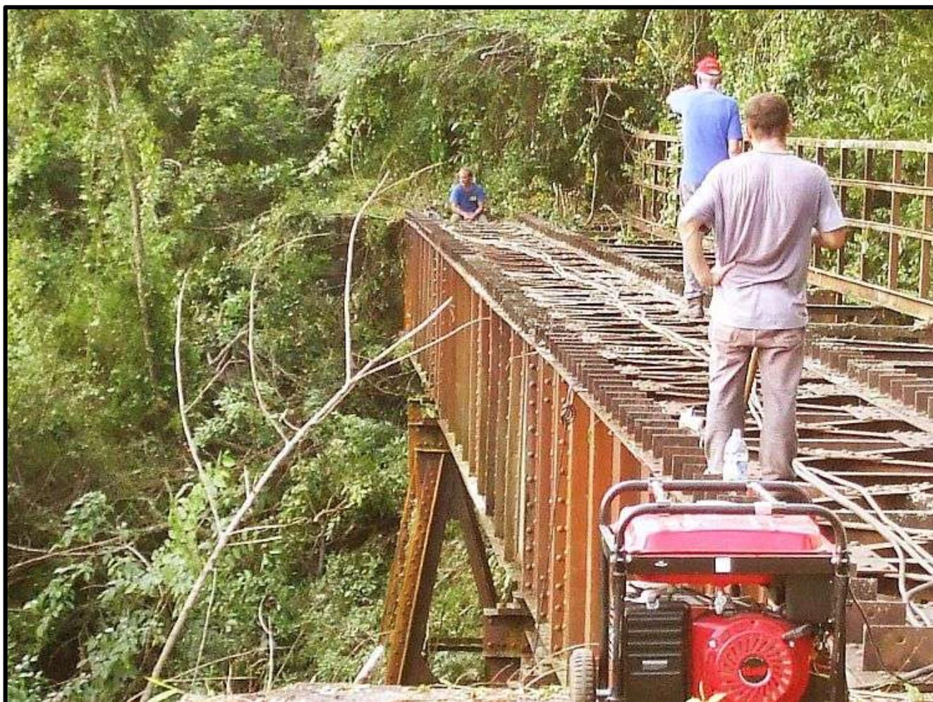
*O viaduto metálico de 48 m de extensão na localidade de Ressacada, após o corte primário da vegetação que obstruía quase totalmente a estrutura, já permitindo uma maior insolação, reduzindo assim a concentração de umidade. A longo prazo o local poderá ser um novo final de linha para o trem histórico cultural do projeto ABPF/Tremtur.*
