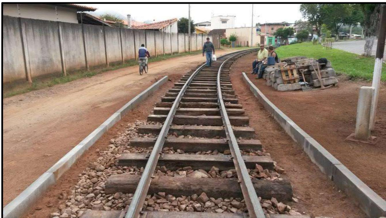
*Acima: Colocação de meio-fio para reter o lastro da via no km 80 + 100m.*
