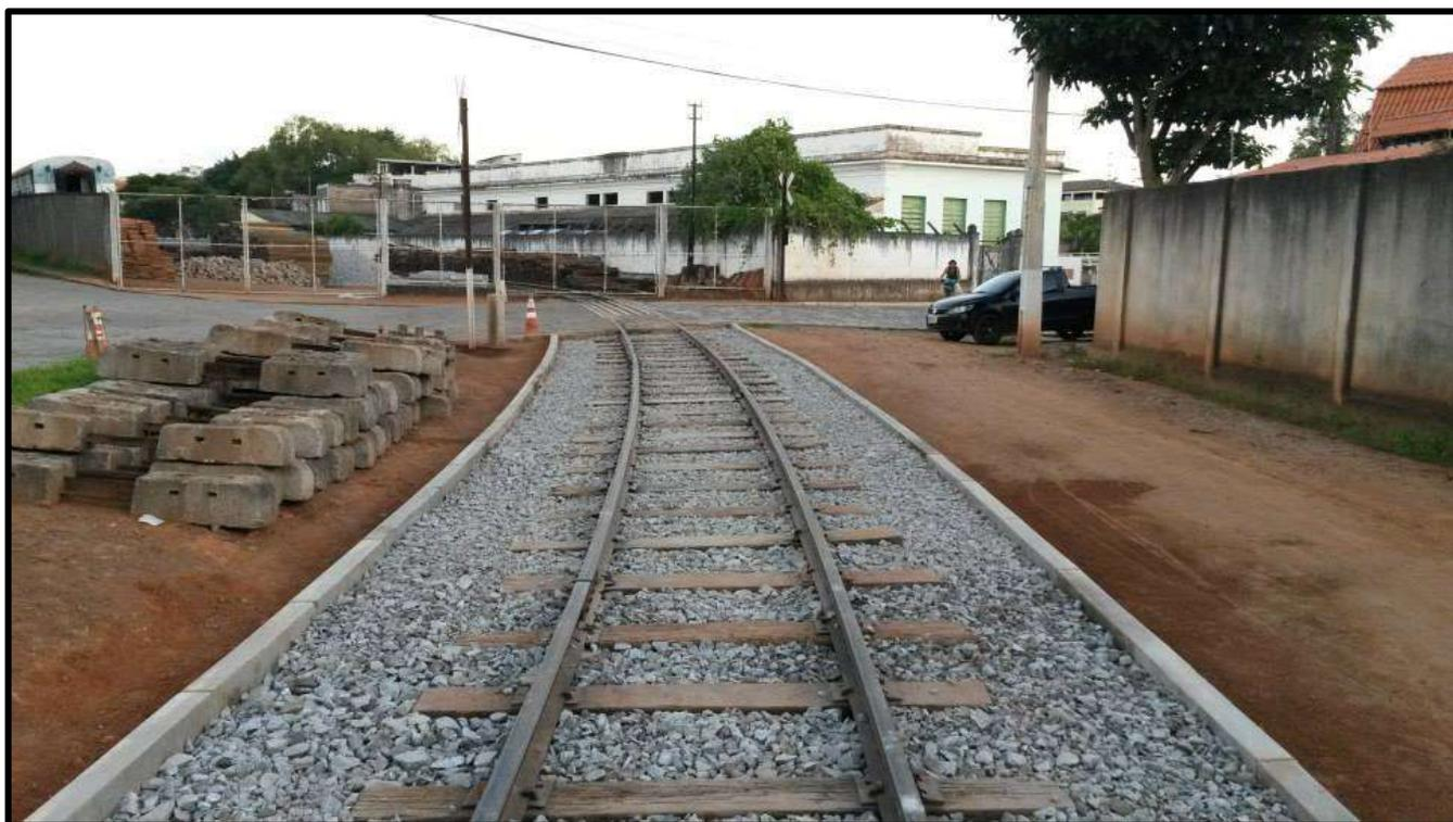
*Trecho de linha no km 80 + 100m após colocação de novo lastro.*
