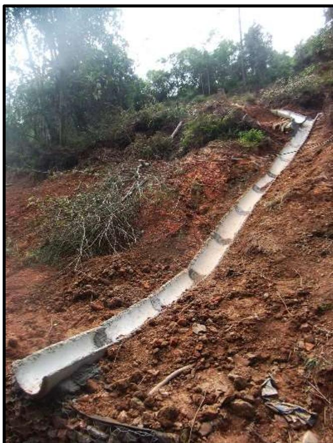
*Valetas pluviais implantadas na encosta do morro do km 0,295 na intenção de melhorar a drenagem da encosta altamente instável. As canaletas foram doadas pela Prefeitura Municipal de Apiúna.*
