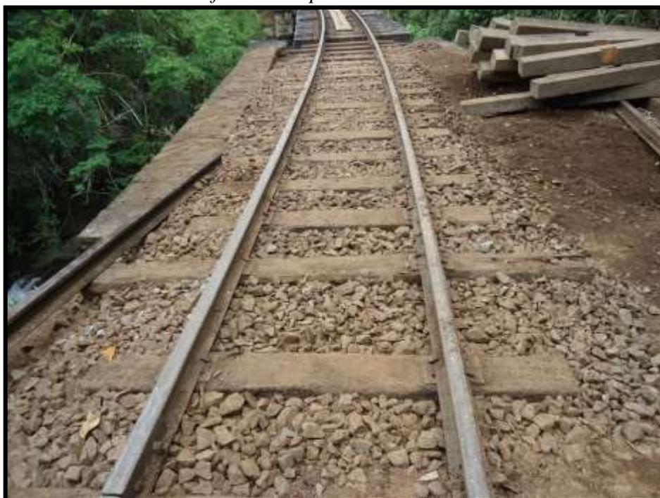
*Aplicação de lastro após instalação dos novos dormentes, na cabeceira superior.*
