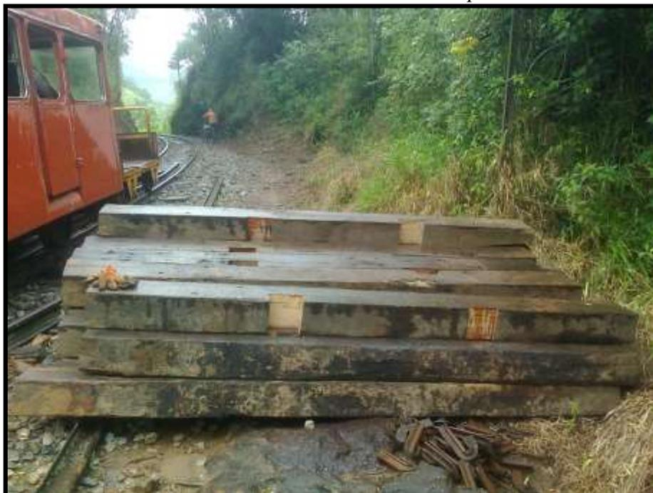
*Novos dormentes para instalação na ponte. Observe a diferença de profundidade entre os entalhes para que seja garantida a super elevação da curva.*
