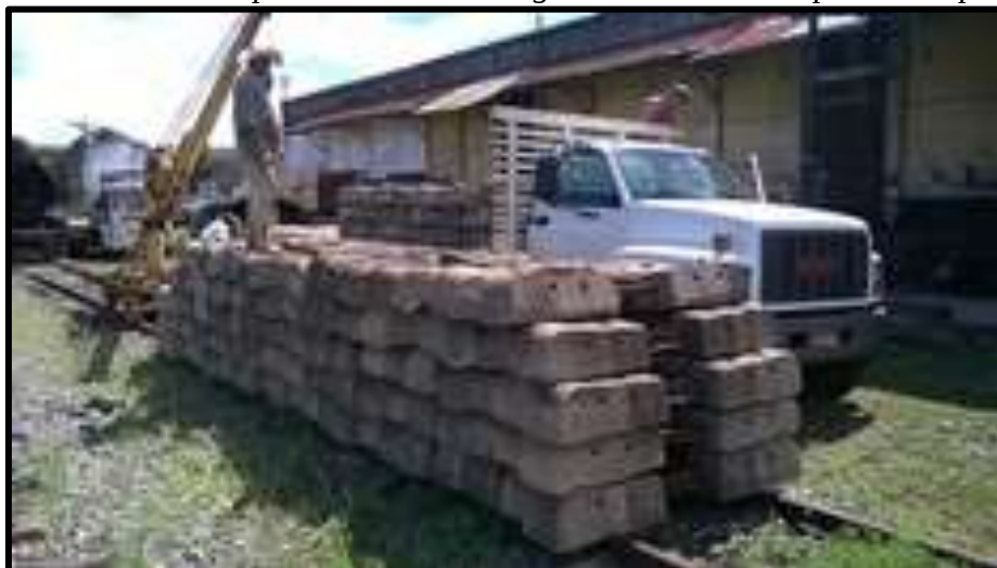
Abaixo: Dormentes prontos sendo carregados no caminhão para transporte.
