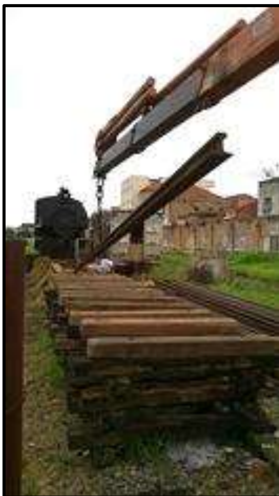
Assentando trilhos na rampa.
