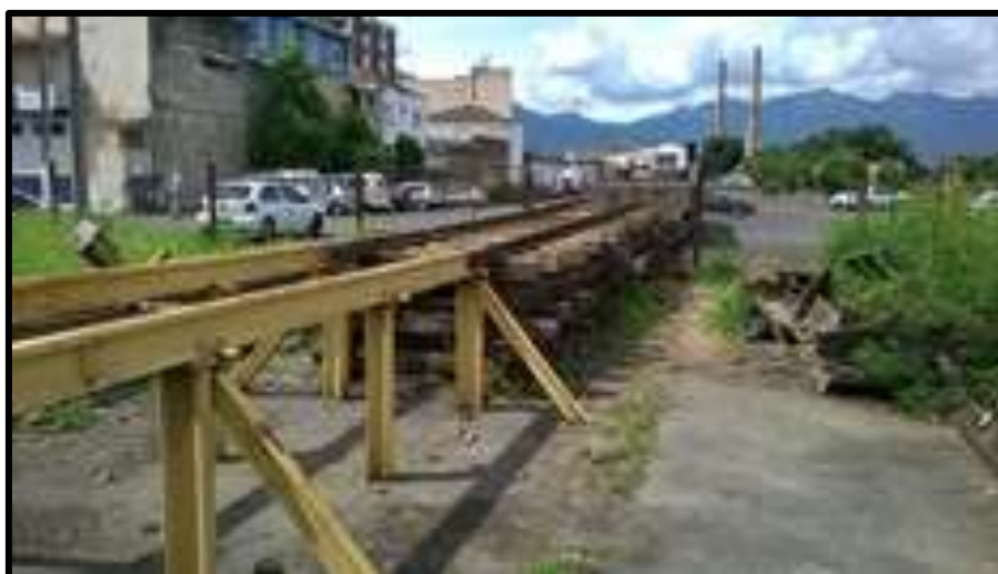
Rampa pronta para uso.
