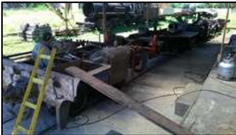
Trabalhos no longeirão da locomotiva 327 em Cruzeiro-SP.
