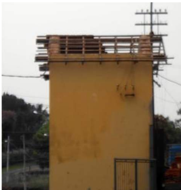
Início da construção do novo telhado da cabine de força
