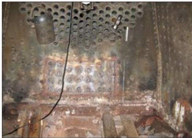
A 505 também passou por reparos no espelho da fornalha
