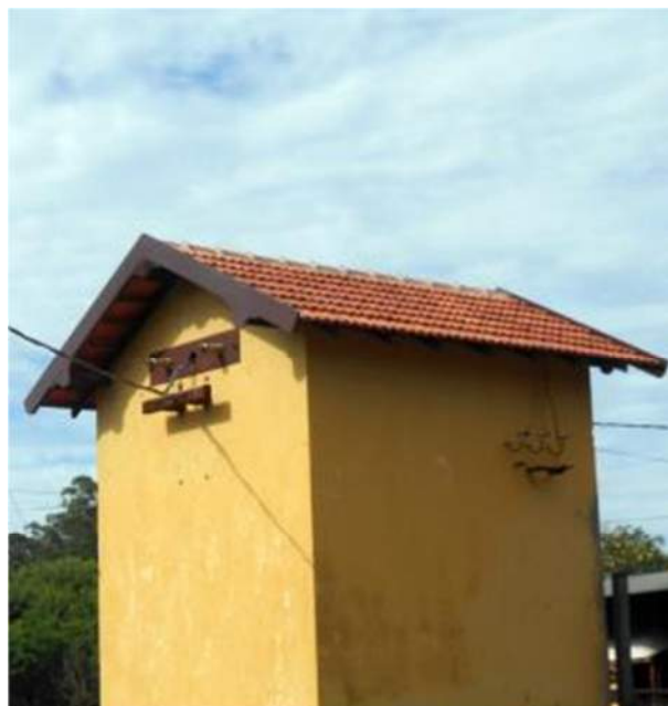
O telhado, já pronto faz parte do conjunto de obras de reformas em Anhumas
