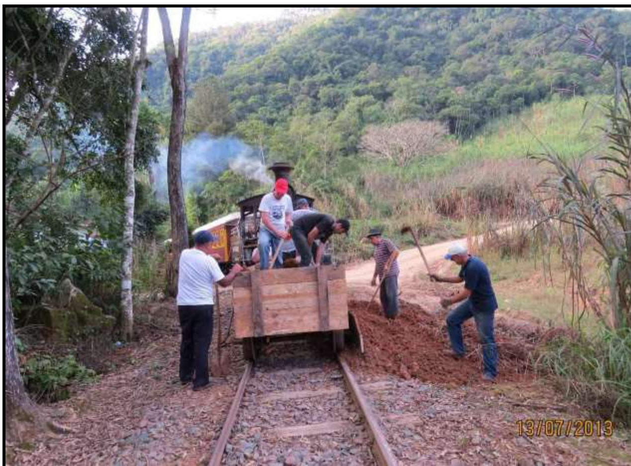
Descarga de barro num bota-fora ao longo da linha. Em atividade a utilíssima carretinha ferroviária, conhecida como “YABADABADU 2”. Foto: Geny Santana Thurow em 14/07/2013.
