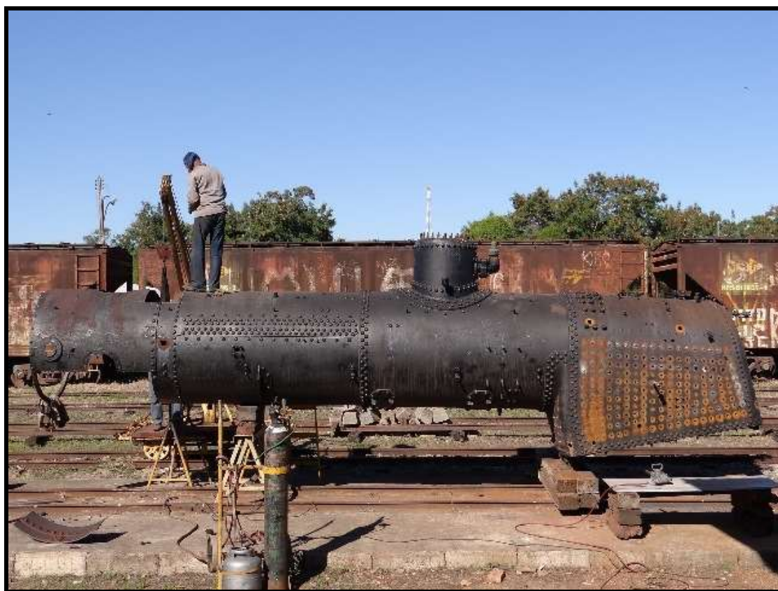
Trabalho de remoção do cabeçote do superaquecedor da locomotiva 522.
