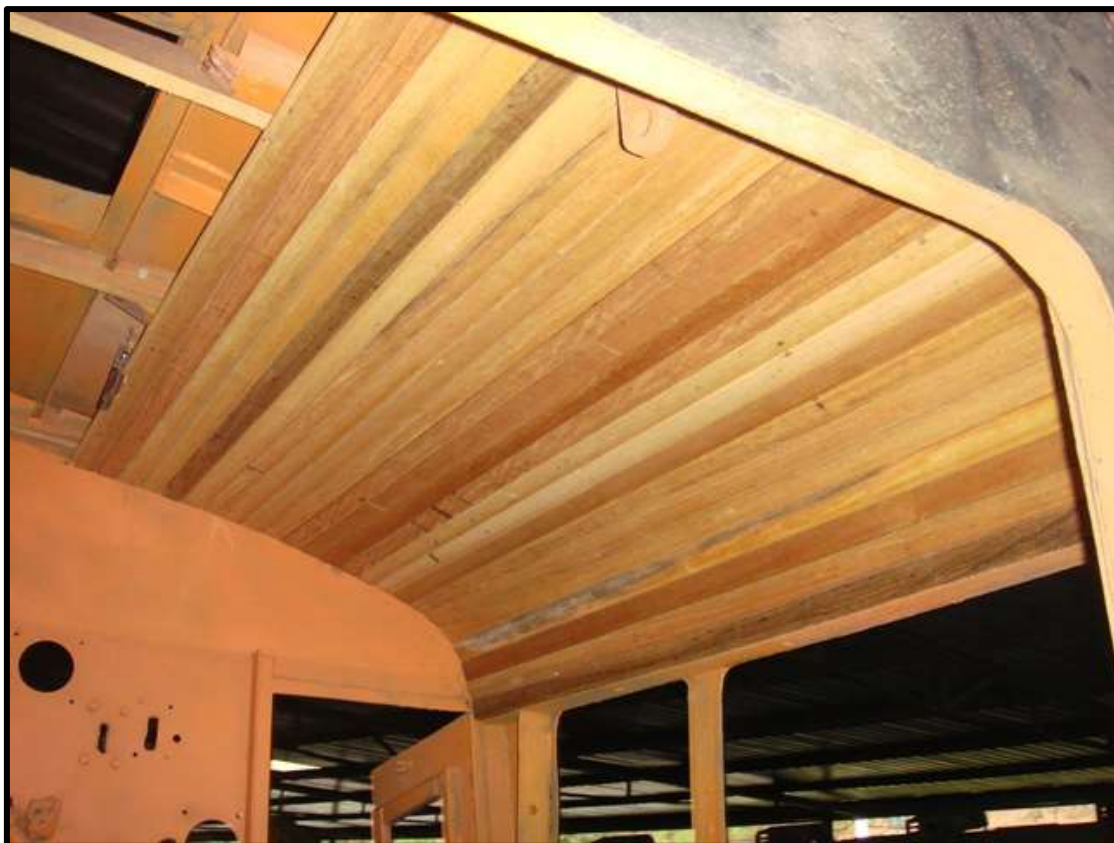
Início da montagem das ripas do forro da cabine da locomotiva articulada nº 204.
