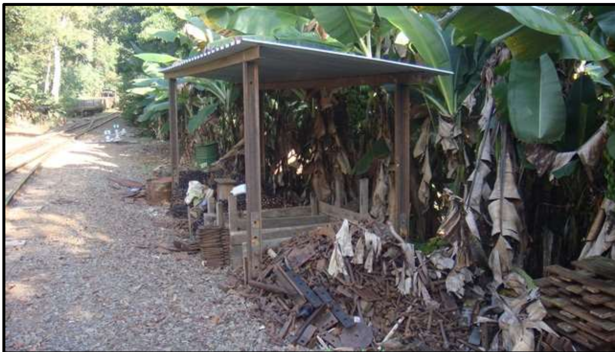
Cobertura para depósito de material de via permanente no pátio de Piratuba.
