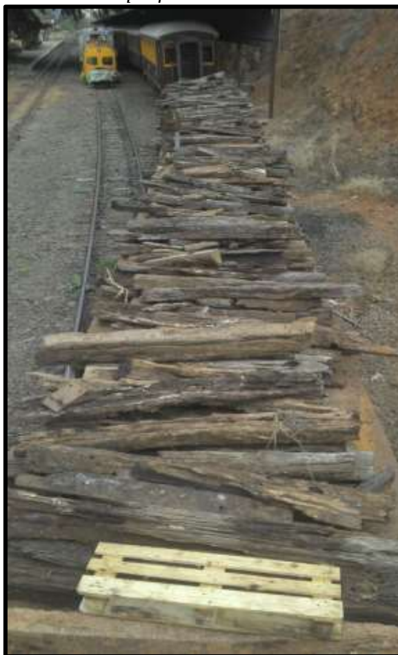
Abaixo: Dormentes velhos que foram substituídos. Foto:Vanderlei Alves.
