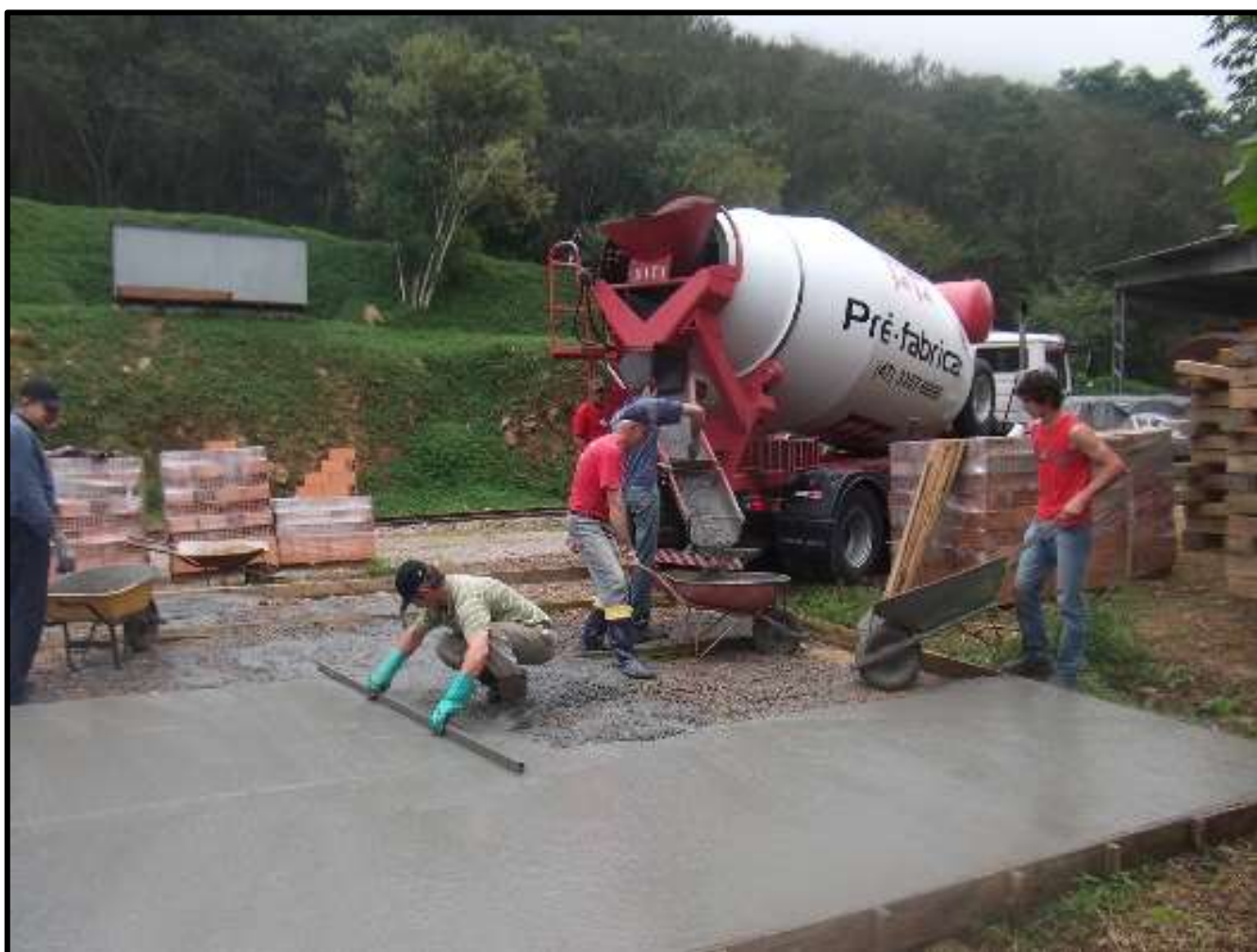
Aproveitando uma brecha no mau tempo, efetuamos a concretagem do piso da futura oficina do NuRVI. O cimento foi patrocinado pela Pré Fabricar Concretos de Ibirama-SC.
