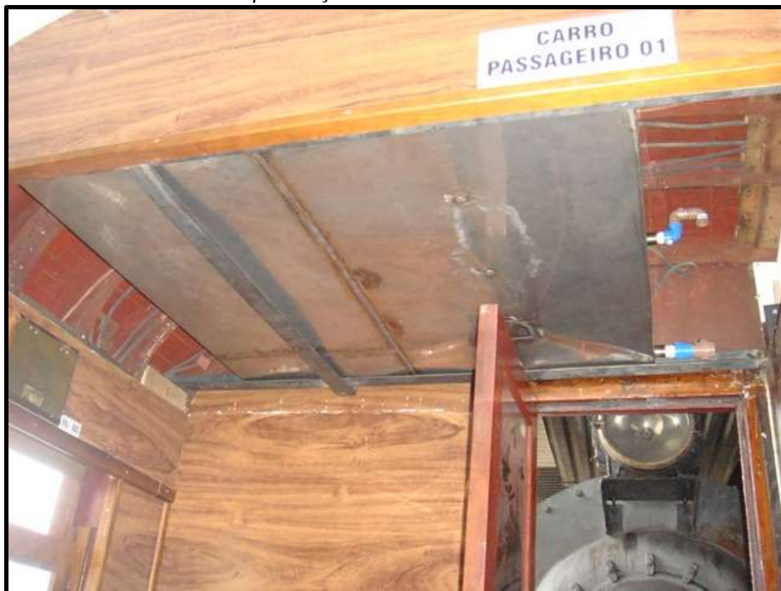
Caixa d'água nova em inox sendo instalada no carro C-01.
