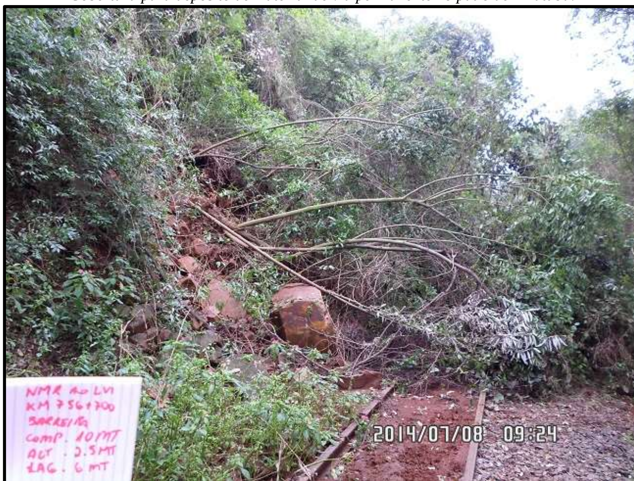
Queda de barreira no km 756 + 700m.
