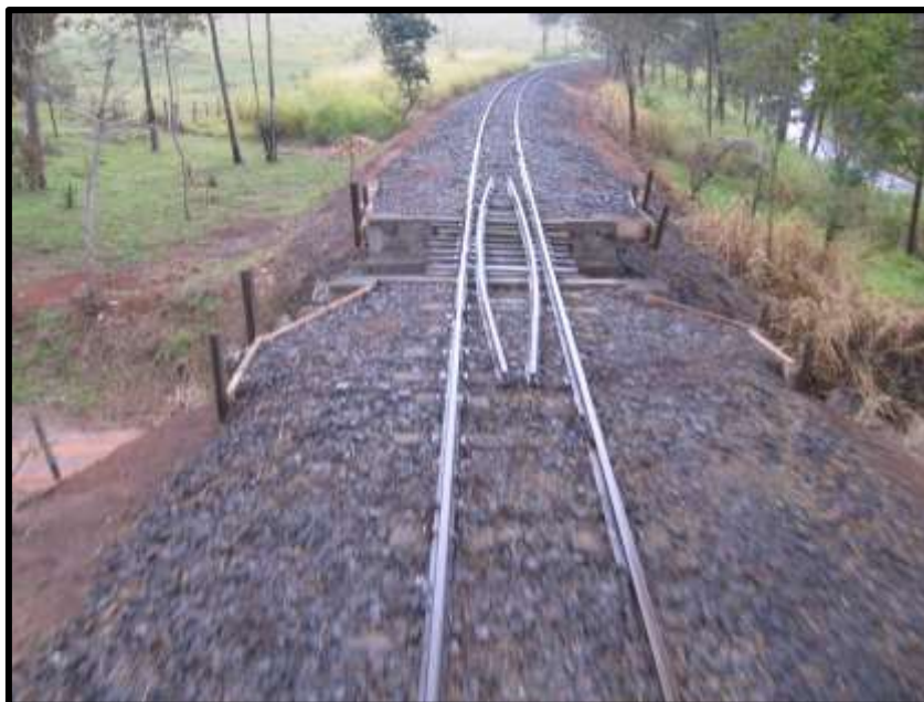
Acima: Instalação de placas de concreto para contenção do lastro na cabeceira do pontilhão. Foto: Hélio Gazetta Filho.
