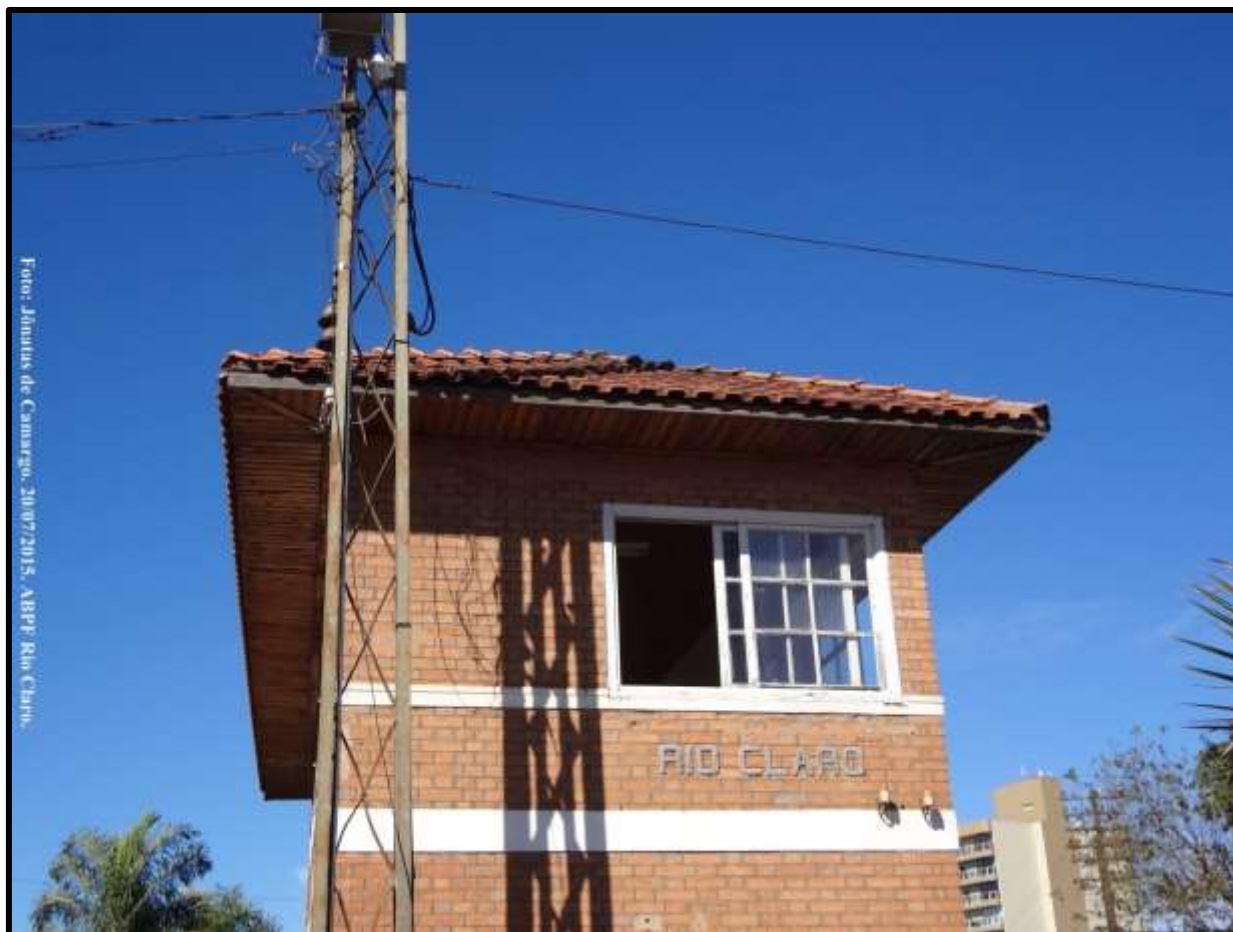
Telhado de nossa sede já reparado.
