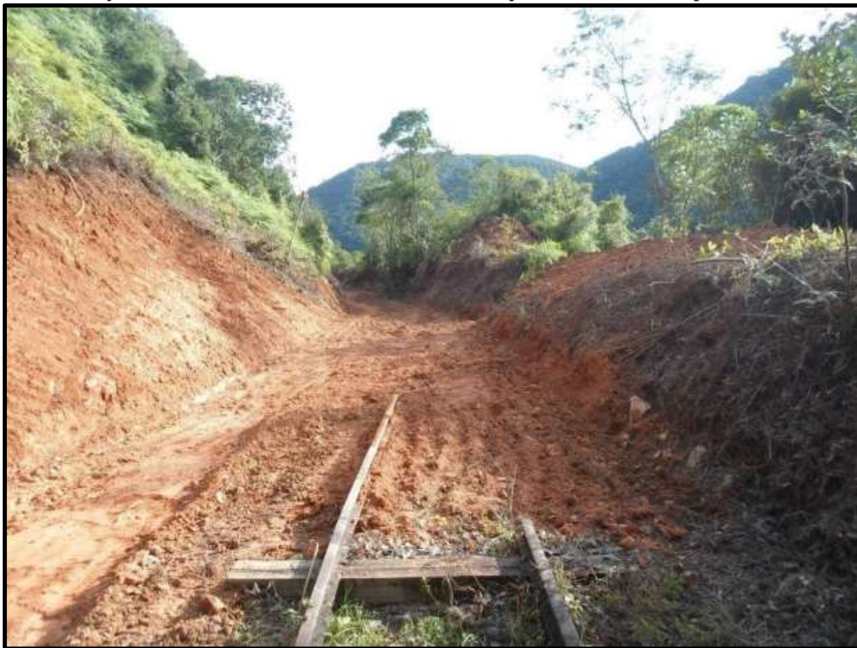
Final dos trilhos implantados e início do trecho a ser prolongado, reaberto no mês de julho.
