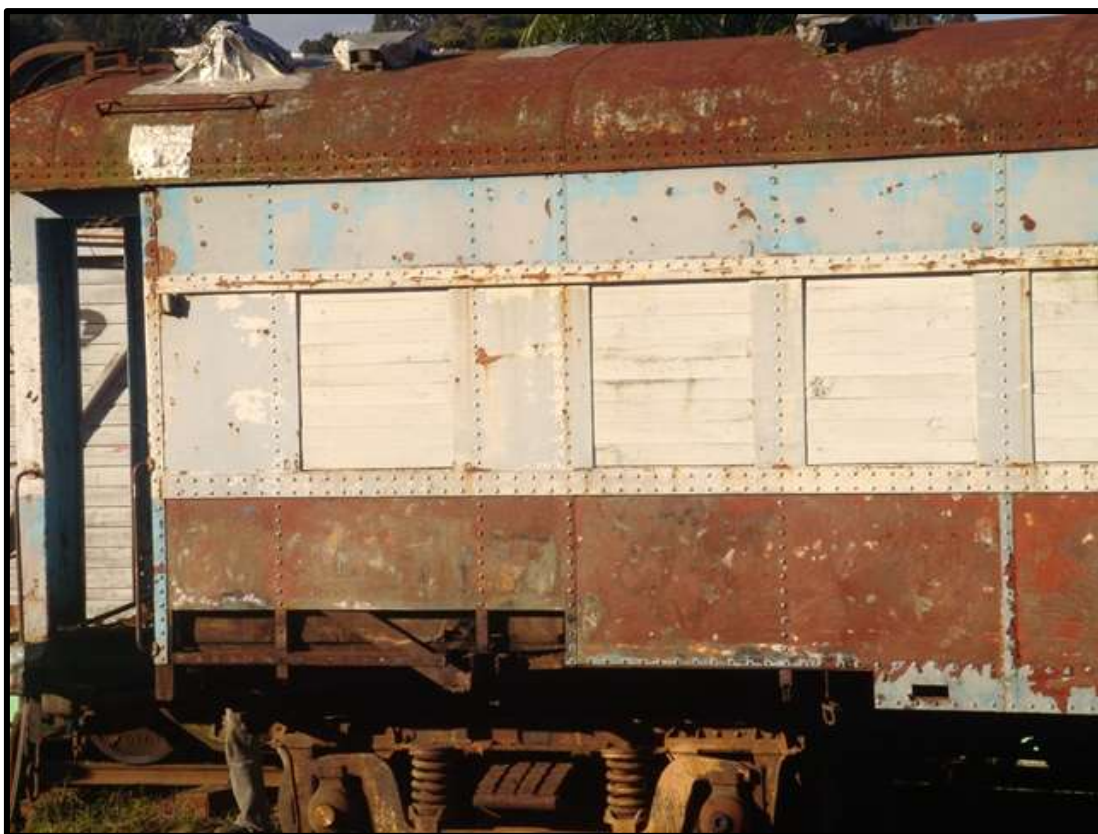
Primeiros recortes para substituição das chapas comprometidas pela ferrugem.
