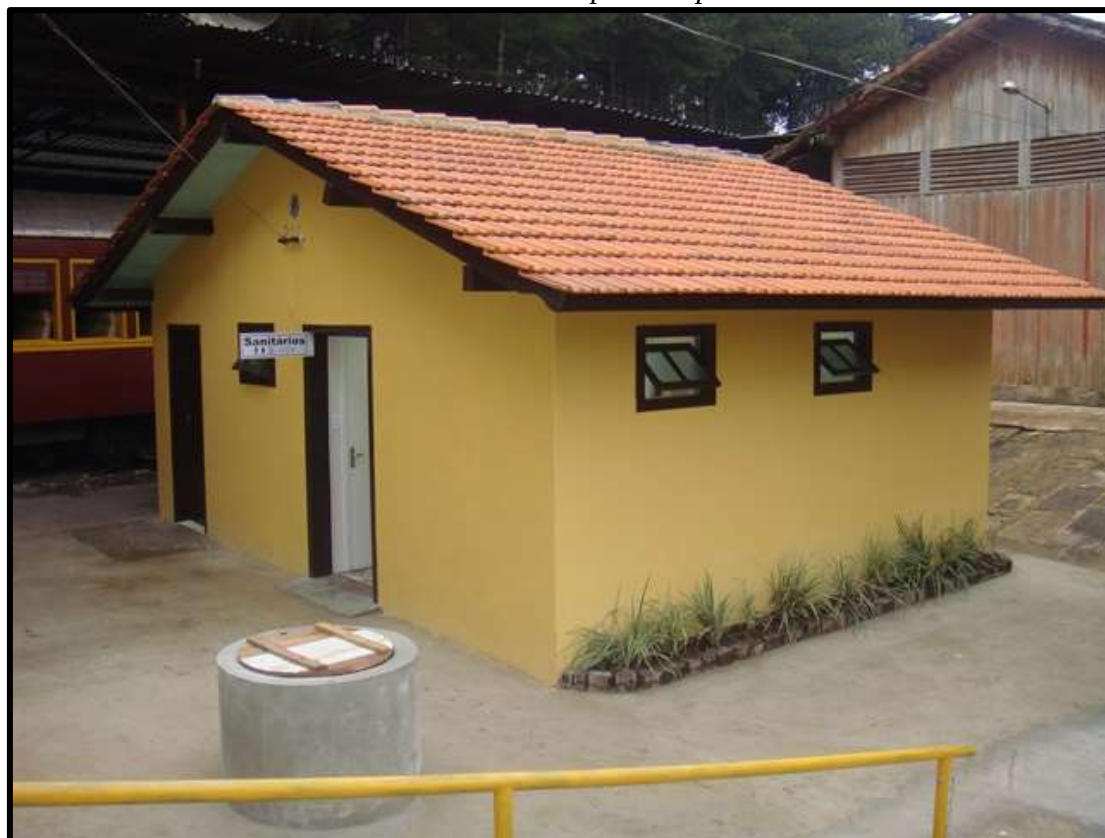
Novo sanitário já pintado conforme as cores originais da estação.
