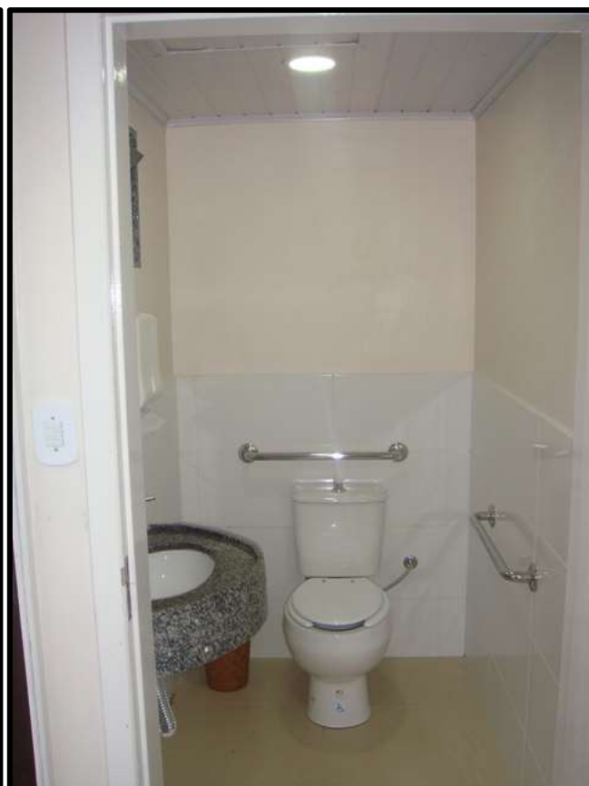
Parte para cadeirante do novo sanitário.
