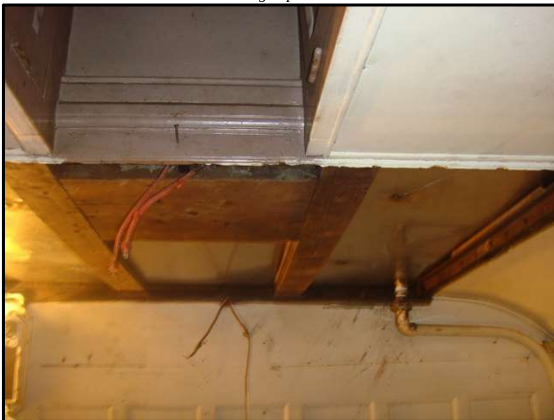
Caixa d'água nova já instalada na cozinha do carro adm. A-02.
