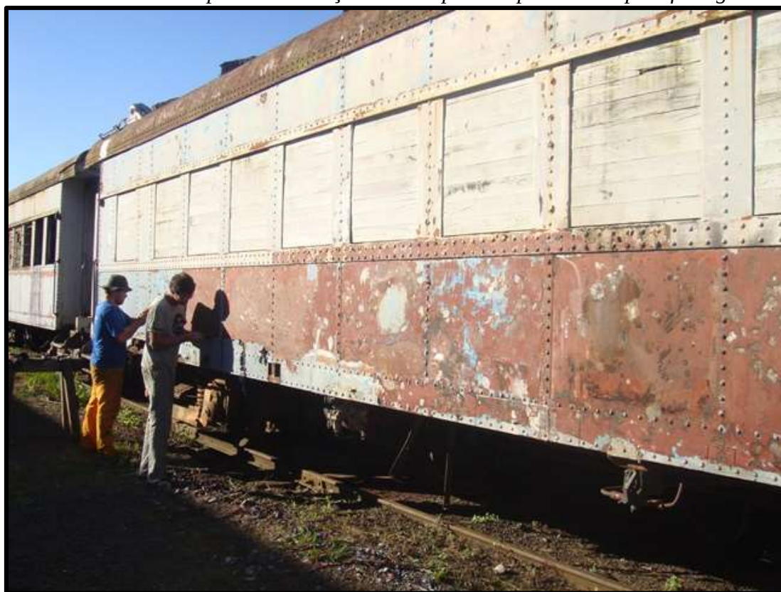
Primeiros trabalhos de retirada da pintura antiga.
