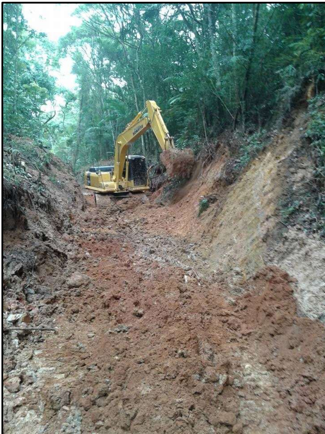
Escavadeira cedida pela Prefeitura Municipal de Apiúna nos trabalhos de reabertura do antigo leito da EFSC. Foto: Otávio Georg Junior em 06/07/2015.
