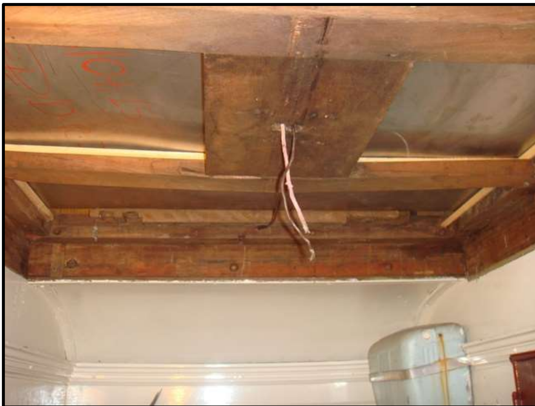
Caixa d'água nova já instalada no banheiro do carro administração A-02.
