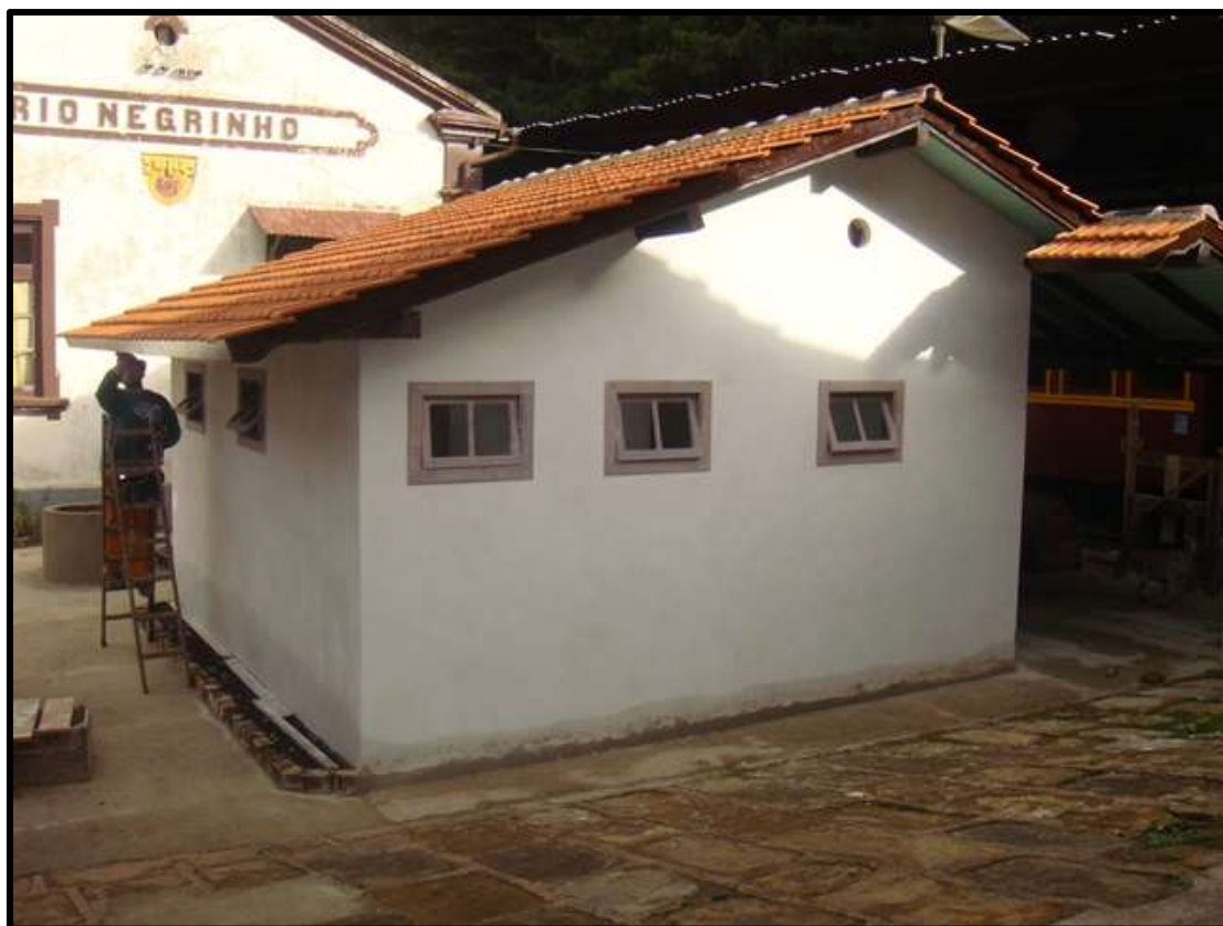
Novo sanitário sendo pintado pelo Iuri.
