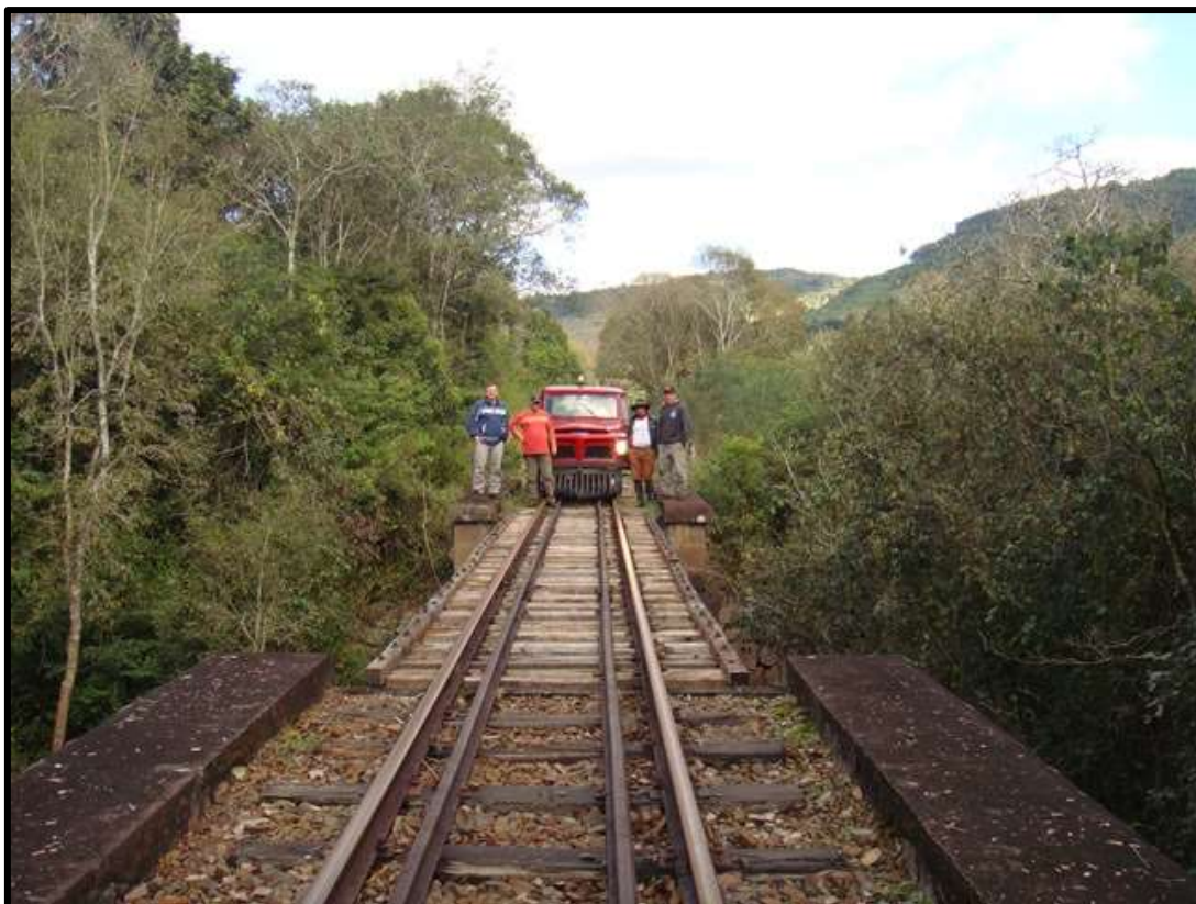
Mestre de linha Jeferson entregando o serviço na ponte do Marata na presença de Everaldo, Nilson e Antônio.
