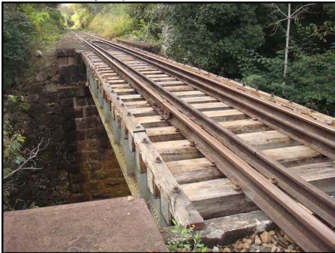
Ponte do Marata no km 850 com nova dormentação.
