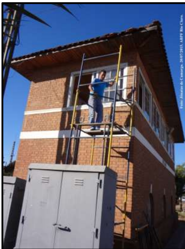
Sr. Marcos Ferreira realizando a montagem do andaime para conserto do telhado. Notem as telhas desalinhadas.
