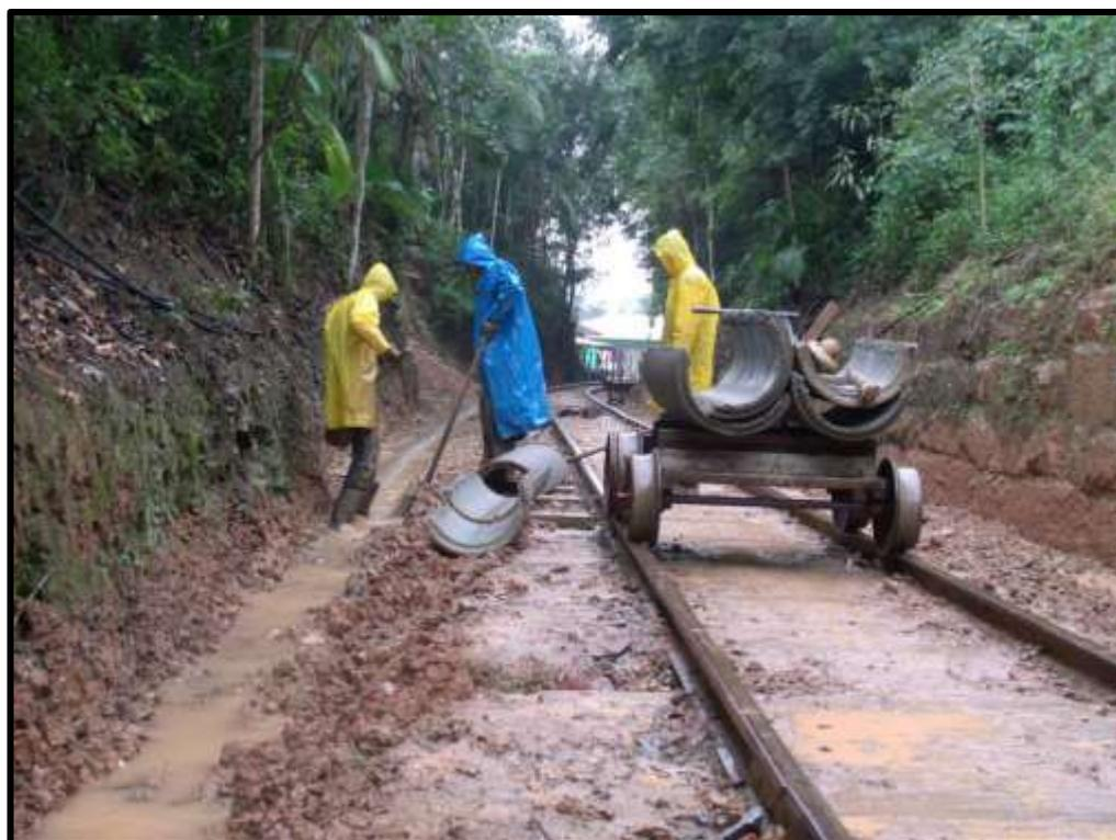
*Colocação de canaletas pluviais para melhorar o fluxo da água ao longo da via evitando a infiltração no lastro. Foto: Johnny Sandro Henschel em 31/05/2014.*
