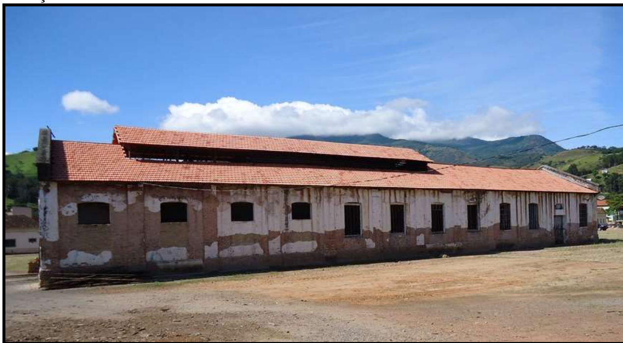
Depósito de locomotivas de Passa Quatro em restauração.
