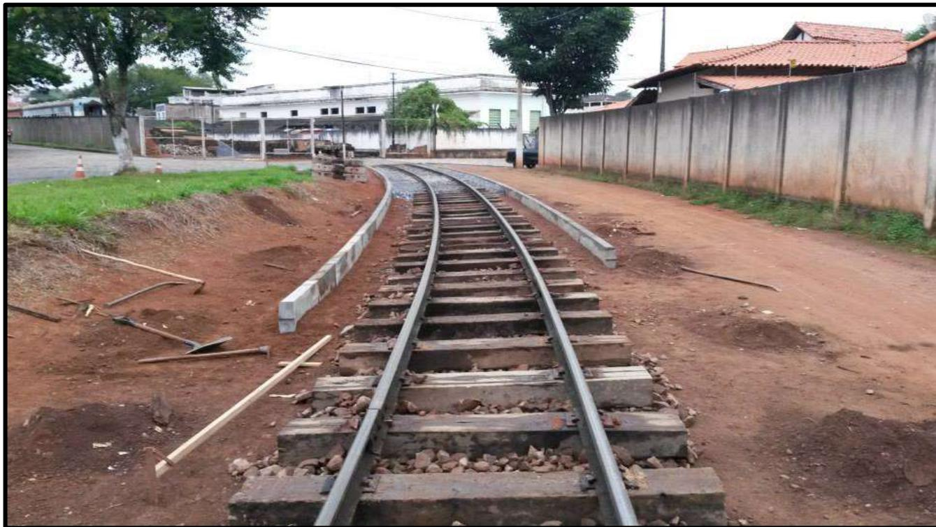
*Trabalhos de recuperação da via-permanente com instalação de meio-fio para contenção do lastro em São Lourenço-MG*
