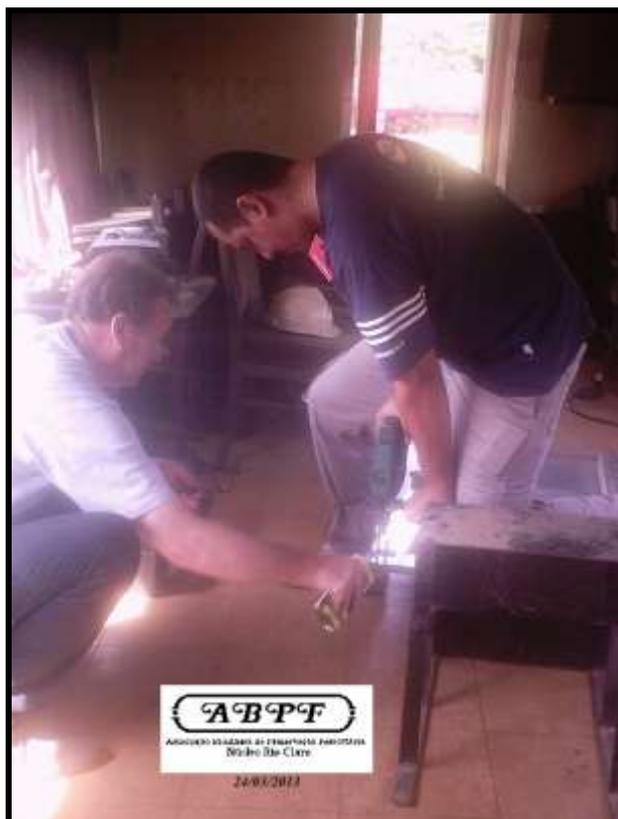
*Acima: diretor Eder e associado Arnaldo realizando a furação da porta para instalação de fechadura de segurança. Abaixo: a primeira fechadura já instalada.*
