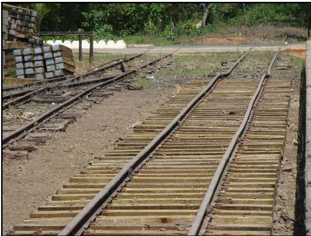
Contraste entre situação da linha (à esquerda) e trecho já recuperado pela ABPF (à direita). Foto: Felipe Sanches.
