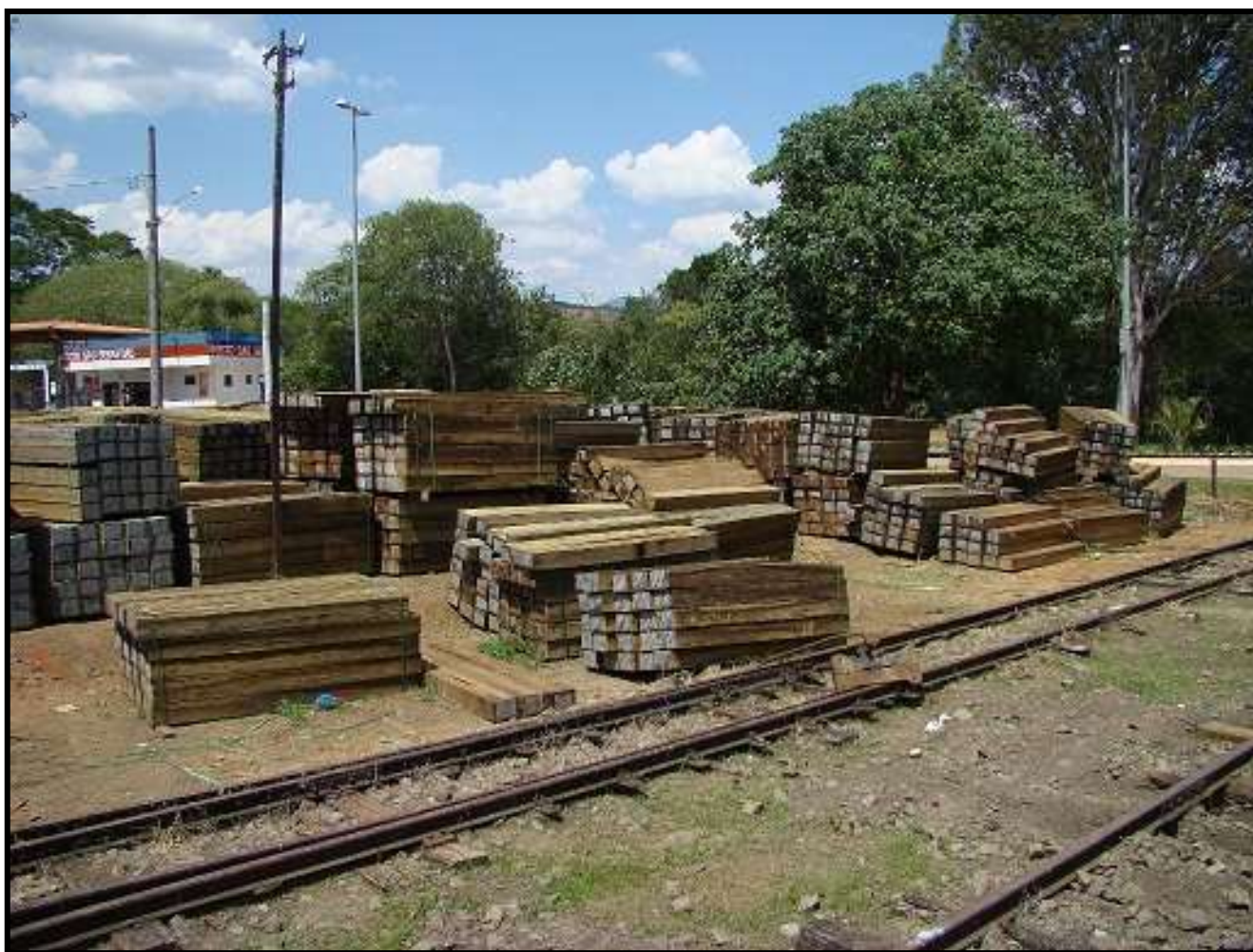
Alguns dos dormentes doados pela VALE para a recuperação da linha entre São Lourenço-MG e São Sebastião do Rio Verde-MG. Foto: Felipe Sanches.
