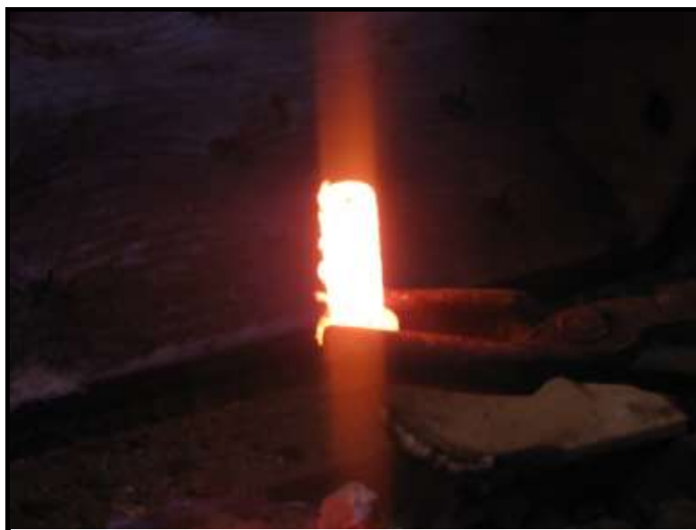
Acima: Rebite aquecido e pronto para instalação.
