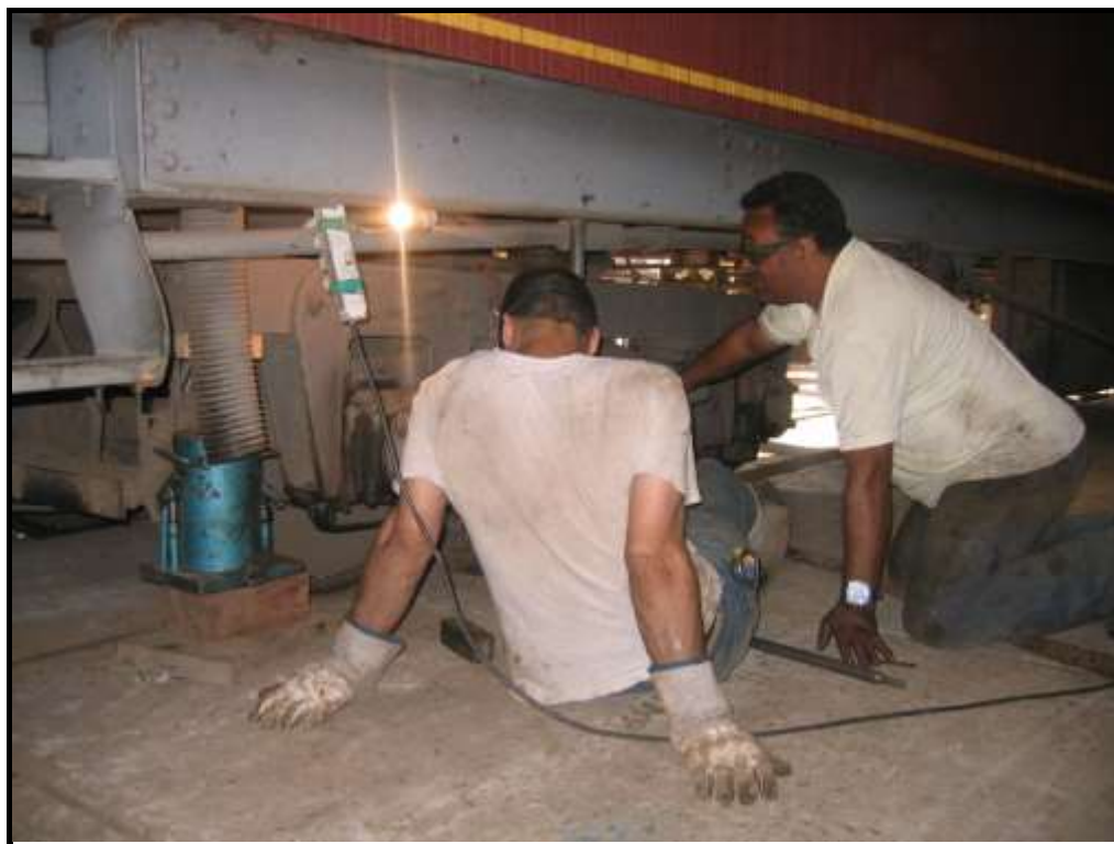
Acima: Modernização do sistema de freios do carro CA-36.
