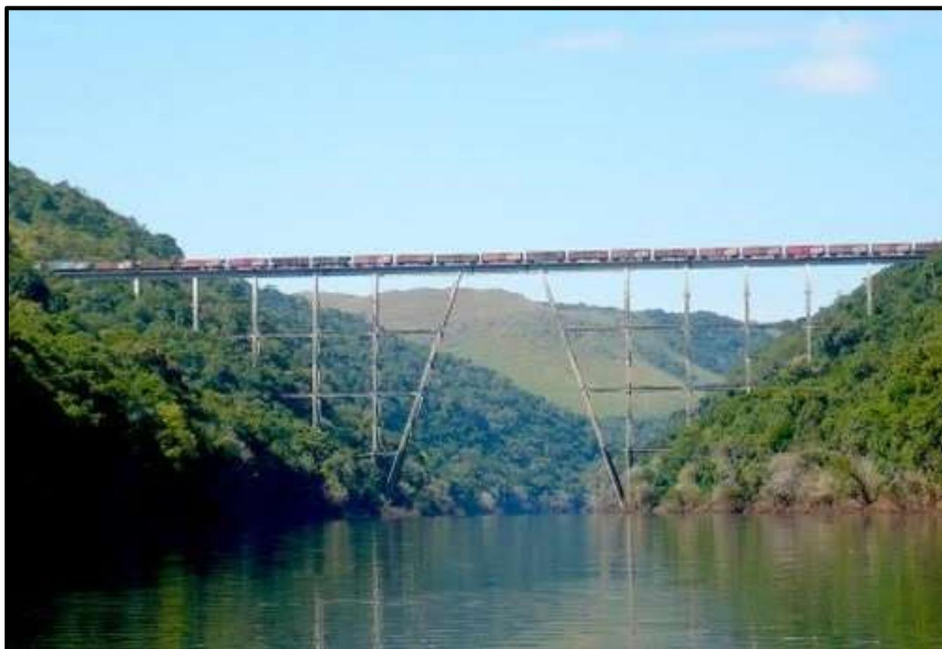
*Ponte que passamos sobre Rio Pelotas km 317,500, com 330 m de extensão e 100 m de altura.*
