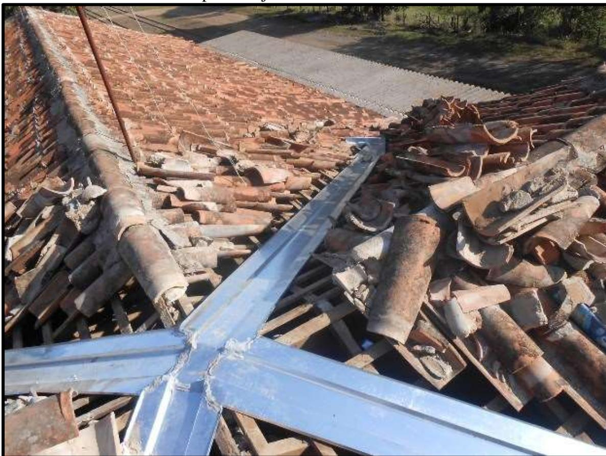
*Novas calhas coletoras instaladas na estação Tanquinho.*
