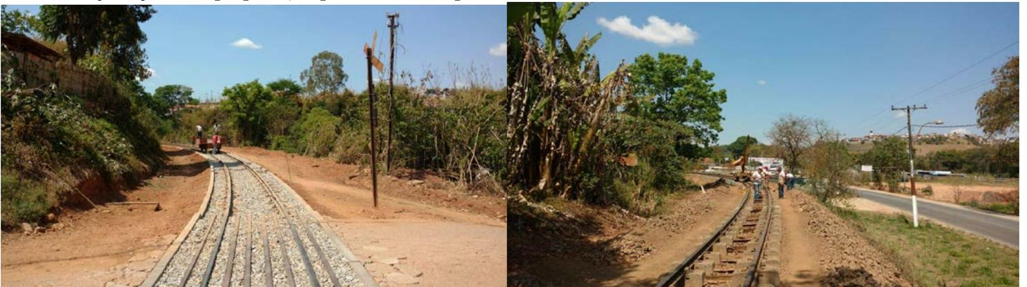
*PN do km 83+300 após a conclusão dos trabalhos e frente de trabalho no mesmo km: substituição de todos os dormentes por de concreto, remoção do lastro para descontaminação e correção da geometria da via*
