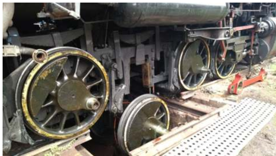
Os serviços emergenciais realizados na Locomotiva Mikado nº 760
