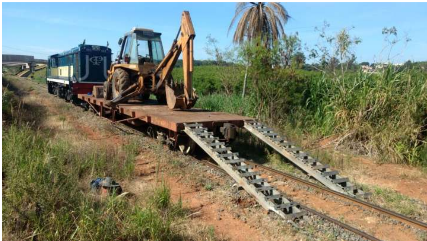
Em tempos chuvosos, crescem as intervenções para manutenção da via.
