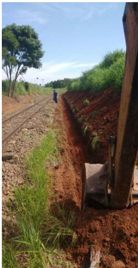
Os trabalhos para troca de dormentes são contínuos.
