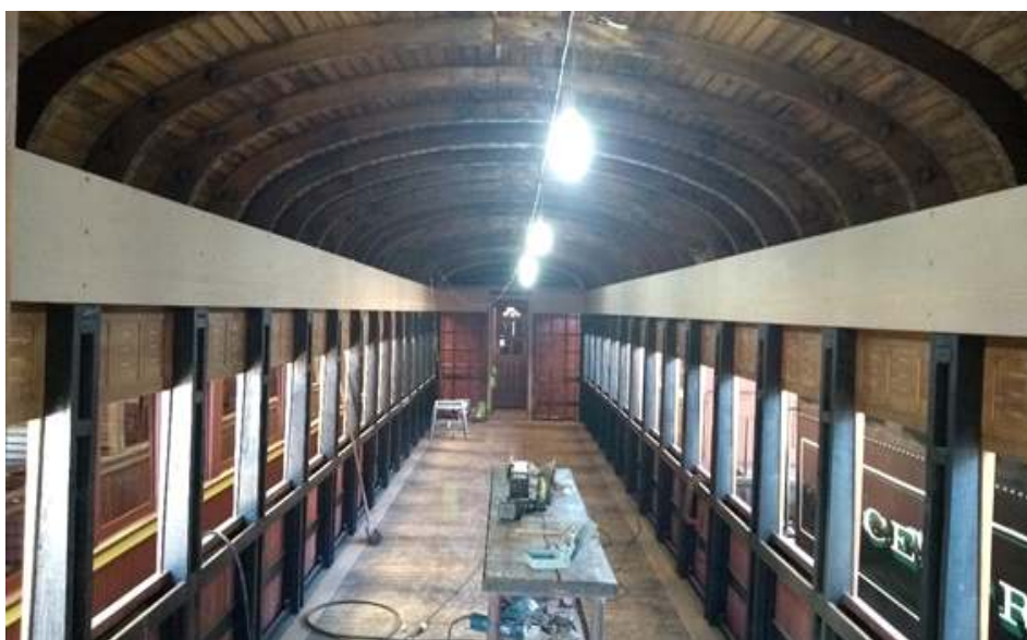
Trabalho de instalação do novo revestimento interno no carro SD-02
