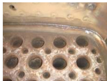
O início dos trabalhos de solda dos estais externos e da fixação da chapa do dedo da fornalha
