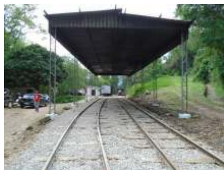
Aspecto do pátio da garagem da composição com a via nivelada e relocada (Luiz Carlos Henkels)
