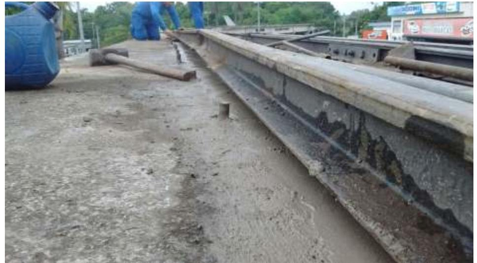
*Substituição de fixações na coa permanente*
