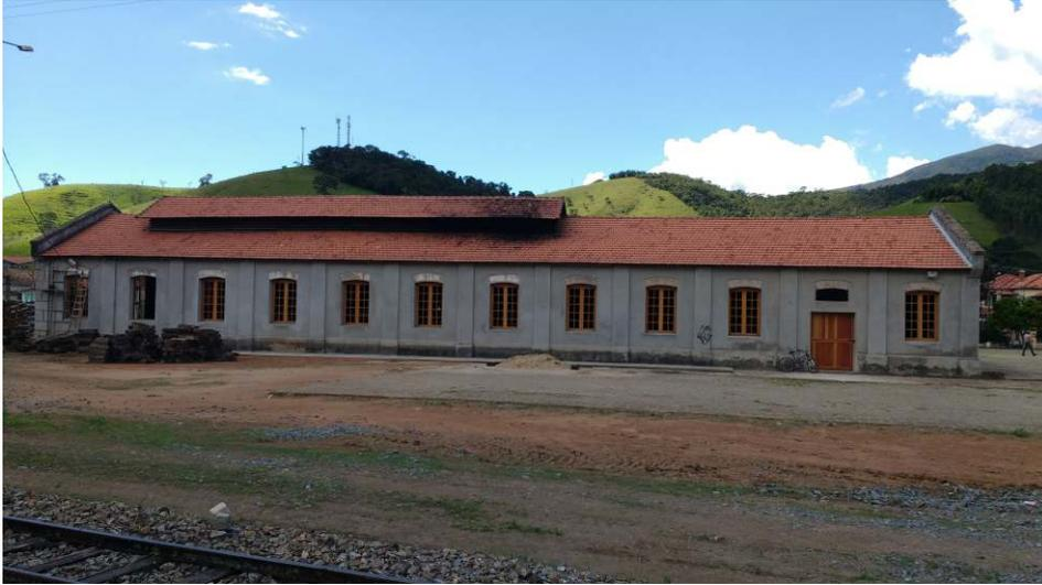
+ Aspecto geral externo do depósito de material rodante, já com as novas janelas e porta confeccionadas na marcenaria de São Lourenço instaladas e novo revestimento em argamassa
