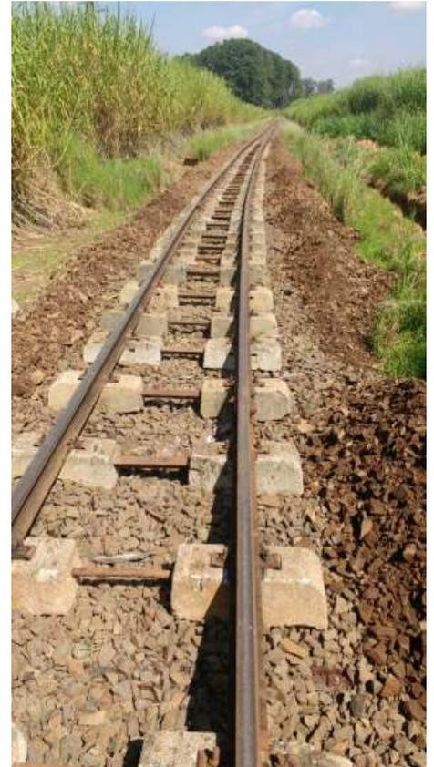
*Nos quilômetros 14 e 15 da VFCJ foram intensos trabalhos de recomposição do lastro da via permanente. Na foto do centro a gôndola distribuidora despeja a brita na via.*
