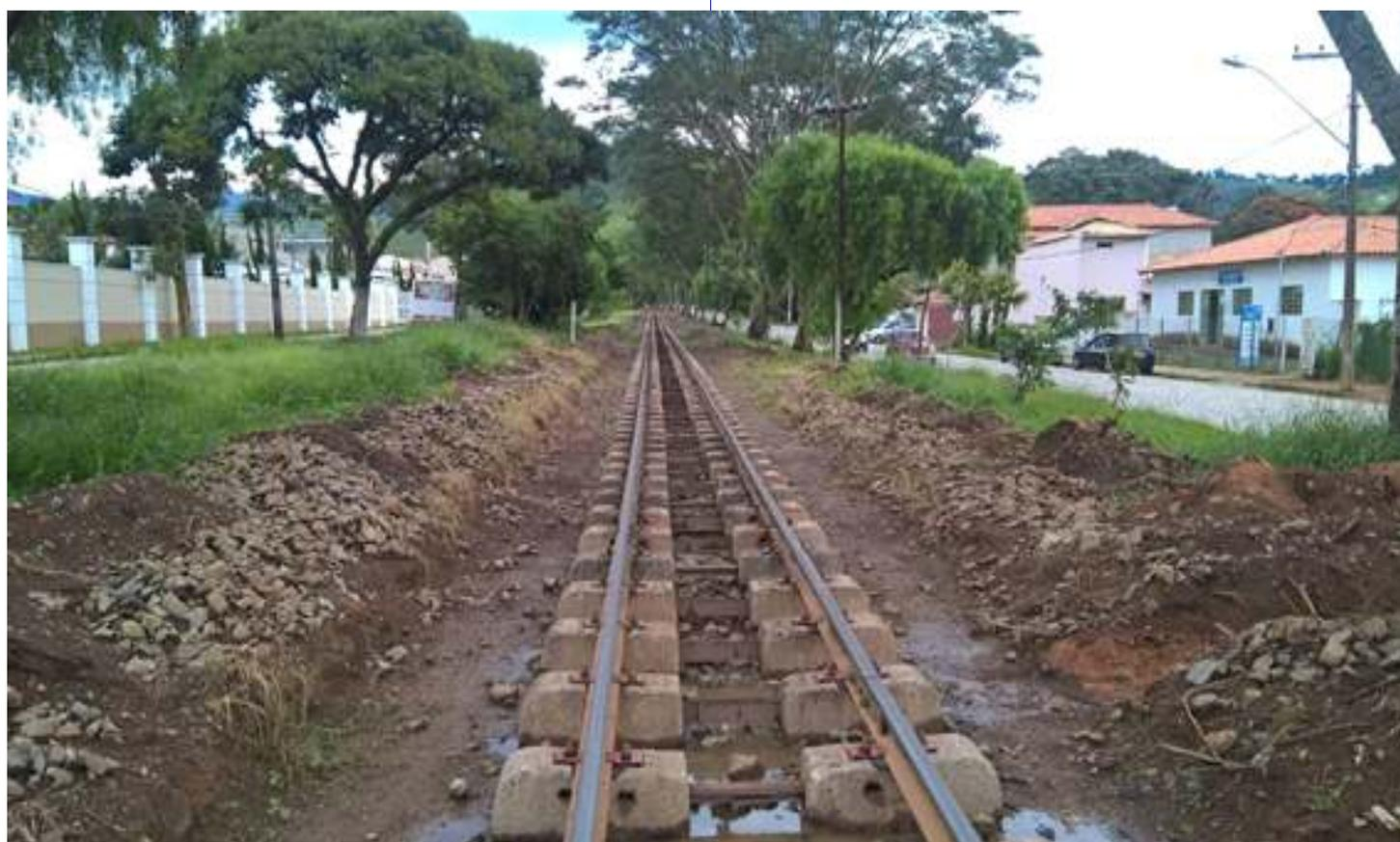
*Trabalhos na via no km 33+200: substituição de todos os dormentes por bi-bloco de concreto, remoção do lastro para descontaminação e correção da geometria da via*
