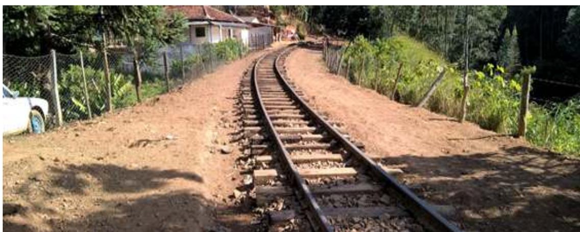
Aspecto do km25+400 após substituição dos dormentes, remoção do lastro para descontaminação e reaplicação; a via foi renivelada e agora está aguardando a chegada do novo lastro para complementação.
