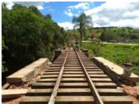
*A via permanente já reinstalada no pontilhão, aguardando a instalação dos contra-trilhos e a colocação de lastro*
