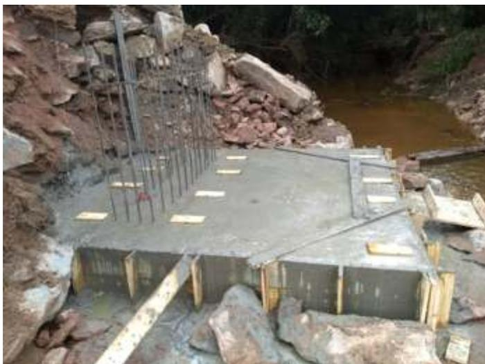
*Concretagem da sapata concluída; ferragens de espera para receber a armadura do pilar.*
