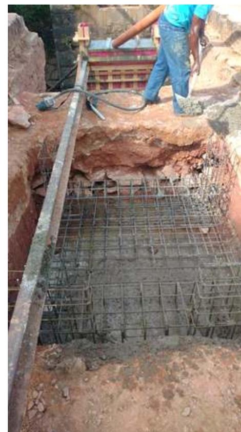
*Duas novas sapatas de apoio foram construídas dentro do caixão de aterro para maior apoio e distribuição da carga*
