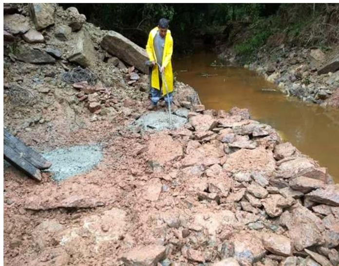
*Construção de fundação profunda com perfuração e injeção de concreto no solo para estabilização.*
