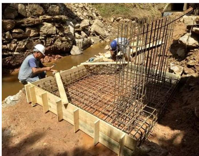
*Após a conclusão da montagem da armadura, montou-se a forma para preenchimento com concreto.*
