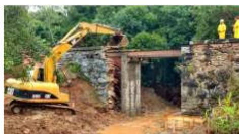
*Instalação das novas vigas de aço no pontilhão*
