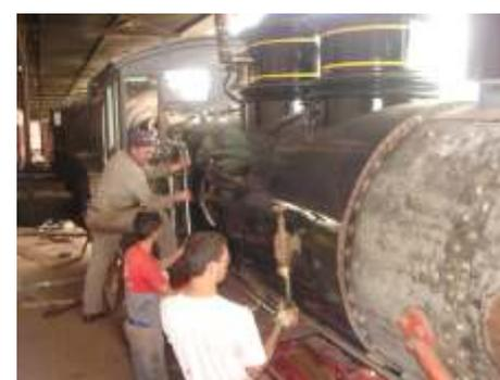
*Últimos acabamentos na madeiramento da cabine e instalação do encanamento dos injetores*
