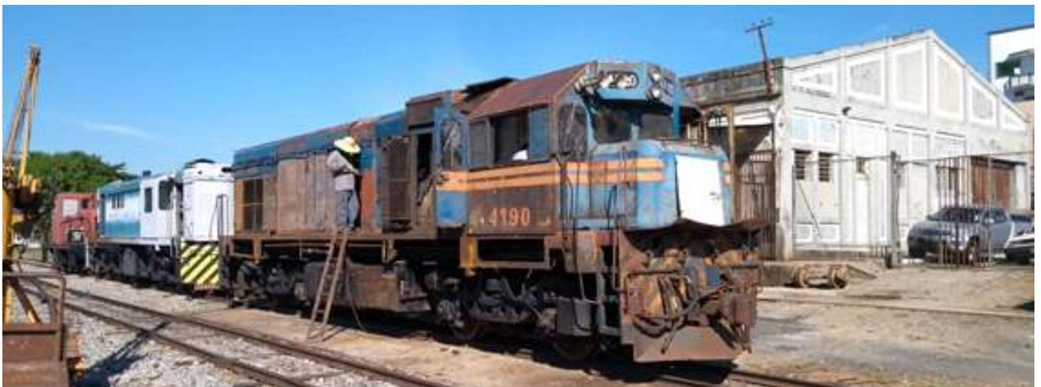
*Trabalhos na G12 nº4190: limpeza geral e preparação para nova instalação elétrica*
