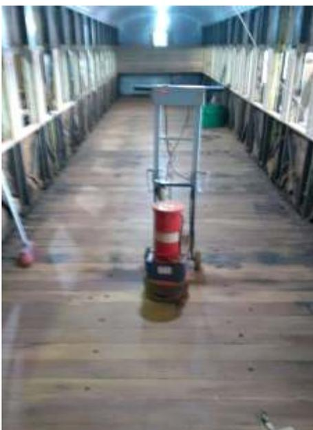
Recuperação do piso original em ipê de 52 mm de espessura, que estava como contra piso do Paviflex
