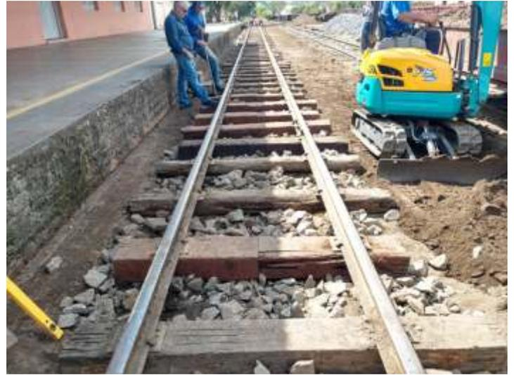
*Aspecto da via após desassoreamento, substituição de dormentes e descontaminação do lastro*
