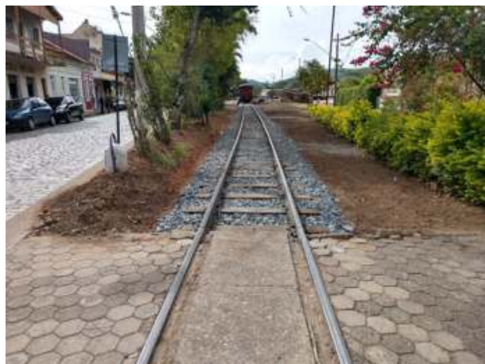
Antes e depois da entrada do pátio da estação de Passa Quatro: remodelação do pátio, com afastamento do amv da pn, substituição de todos os dormentes, desassoreamento da via, alinhamento e aplicação de novo lastro
