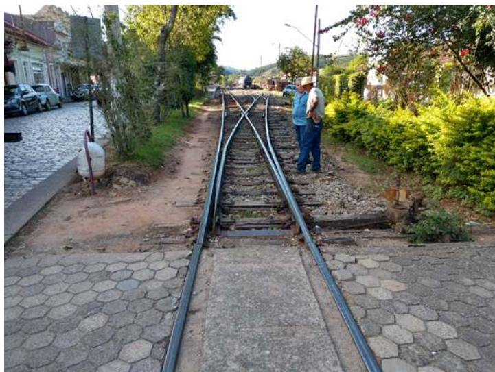
Antes e depois da entrada do pátio da estação de Passa Quatro: remodelação do pátio, com afastamento do amv da pn, substituição de todos os dormentes, desassoreamento da via, alinhamento e aplicação de novo lastro
