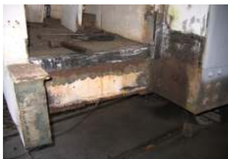
Detalhes da caldeiraria. Foto de Helio Gazetta Filho.
