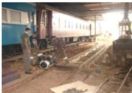
Montagem da linha com 22 metros para manutenção e reforma de locomotivas e implantação de um AMV de aceso
