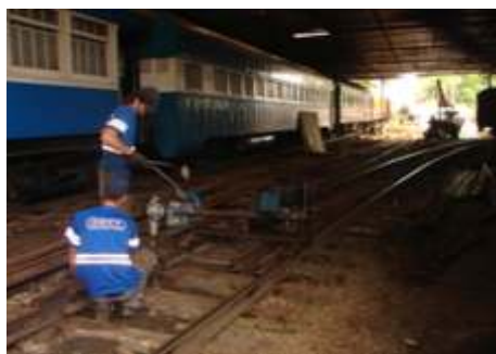
Montagem da linha com 22 metros para manutenção e reforma de locomotivas e implantação de um AMV de aceso
