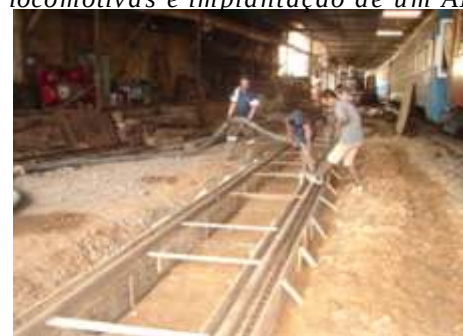
Montagem da linha com 22 metros para manutenção e reforma de locomotivas e implantação de um AMV de aceso
