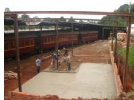
Montagem da primeira parte da estrutura da cobertura e o piso de 180m 2
