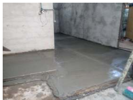
Aspecto da reforma no interior do prédio da estação de Piratuba na área da pequena oficina
