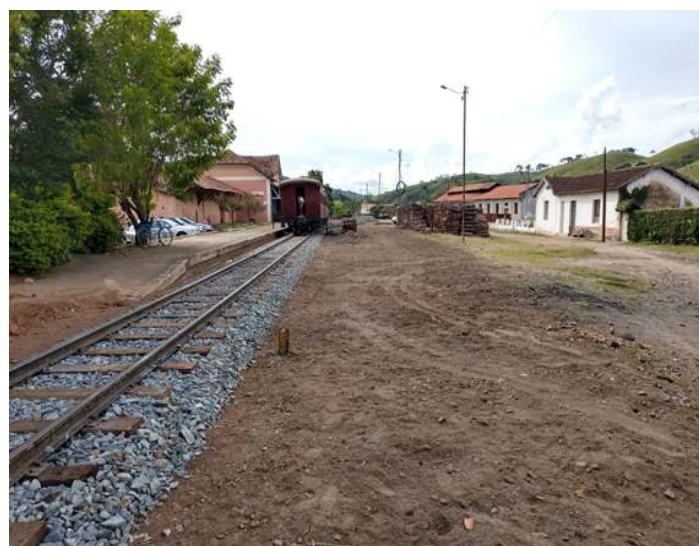
Aspecto do pátio antes e após as intervenções: afastamento do amv da pn, substituição de todos os dormentes, desassoreamento da via, alinhamento e aplicação de novo lastro
