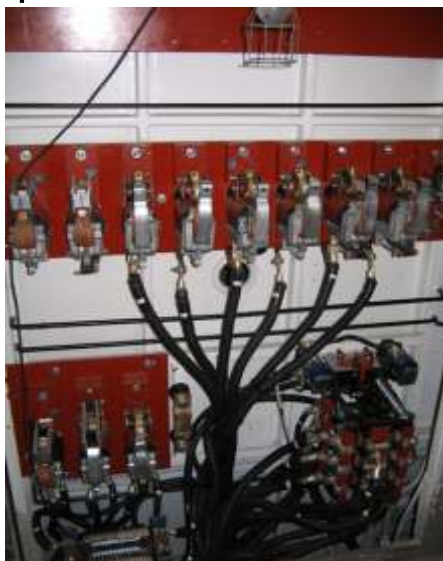
Painel elétrico da locomotiva GE 3128, sendo remontado. Foto Helio Gazetta.
