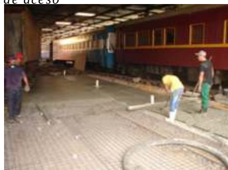
Montagem da linha com 22 metros para manutenção e reforma de locomotivas e implantação de um AMV de aceso
