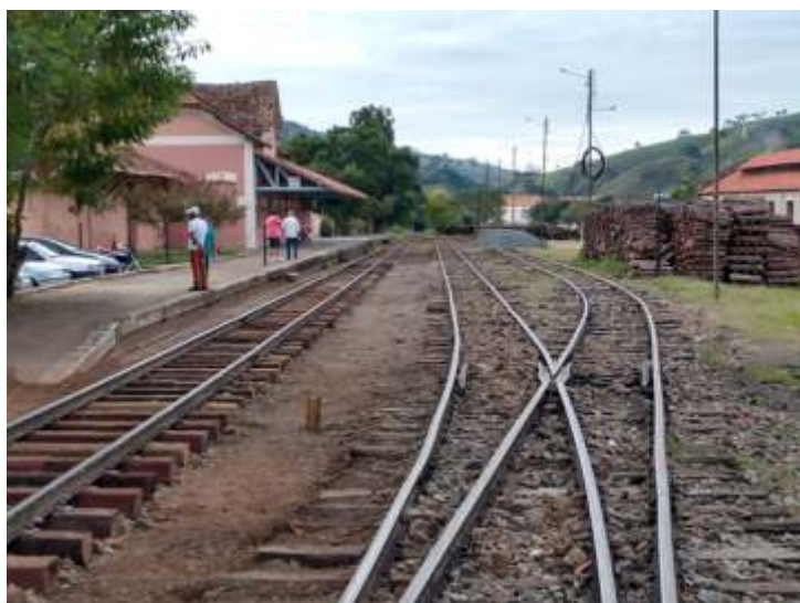
Aspecto do pátio antes e após as intervenções: afastamento do amv da pn, substituição de todos os dormentes, desassoreamento da via, alinhamento e aplicação de novo lastro
