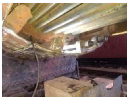
O Trecho da “barriga” da caldeira que foi removido para substituição já com uma parte colocada, com as fixações e tirantes da fornalha
