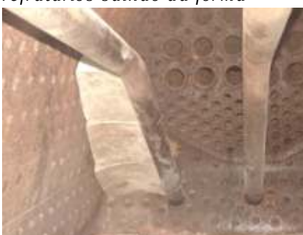
Instalação dos tijolos refratários no interior da fornalha junto aos novos tubos
