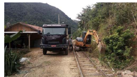
Desobstrução de canalização pluvial ao longo da via férrea, proximidades do Km 1,5. (Otávio Georg Junior)
