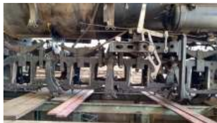
Os feixes de mola, balacins e braços já instalados na 1424.
