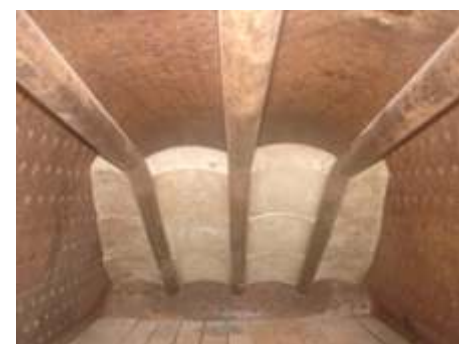
Instalação dos tijolos refratários no interior da fornalha junto aos novos tubos
