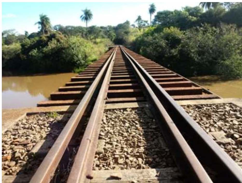
Ponte do rio Atibaia já concluída a troca de dormentes. Foto de Marcio Silva.
