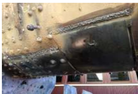
As novas chapas já soldadas na caldeira
