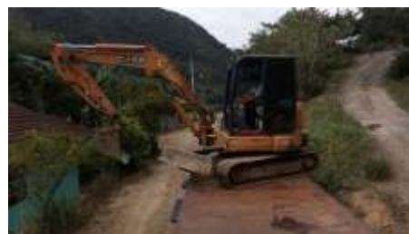
O vagão prancha continua sendo de grande utilidade nos trabalhos de manutenção da via. (Otávio Georg Junior)
