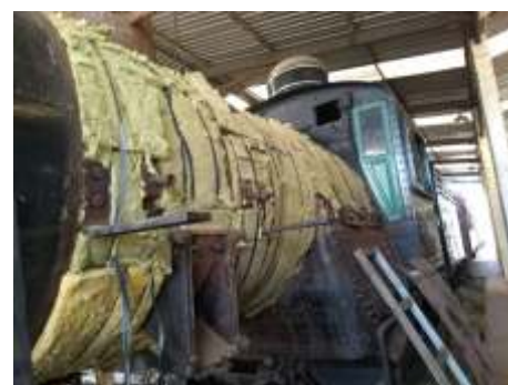
Instalação do novo isolamento térmico na caldeira.
