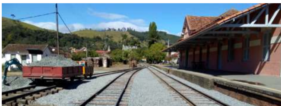
Aspecto do pátio concluído, com novo lastro aplicado
