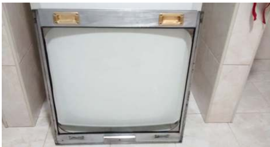
Janela do maquinista já restaurada e com vidro novo. Foto de Helio Gazetta Filho
