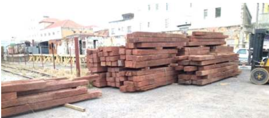
Esse será o primeiro passo do projeto que visa recuperar todo o trecho até o túnel grande, na divisa do estado com Minas Gerais, perfazendo o total de 24 quilômetros.
