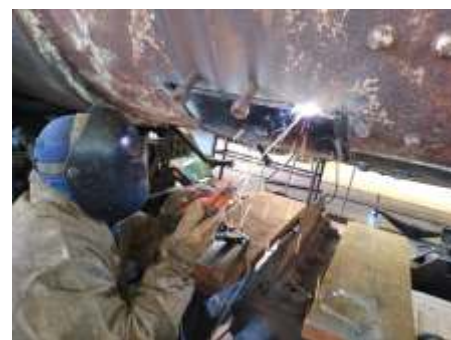
Soldagem de nova chapa na “barriga” da caldeira
