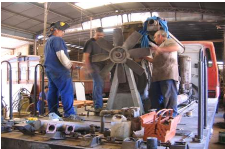
Instalação da hélice, após fixação do motor diesel. Foto de Helio Gazetta Filho
