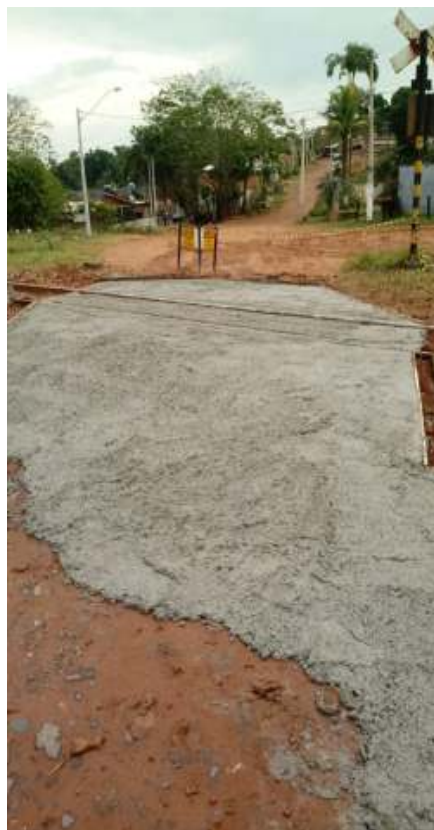
PN após concretagem
