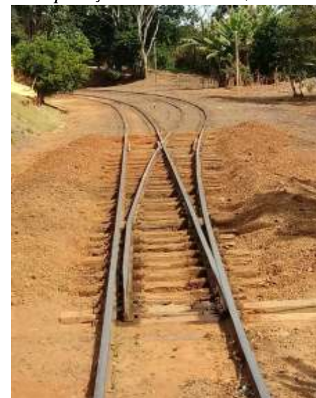
AMV de Anhumas sendo limpo para reforma
