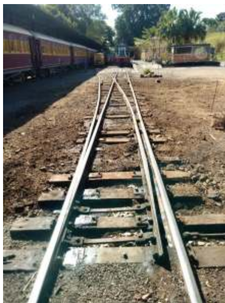
Manutenção AMV de Anhumas – lado Guanabara e outros serviços na via permanente
