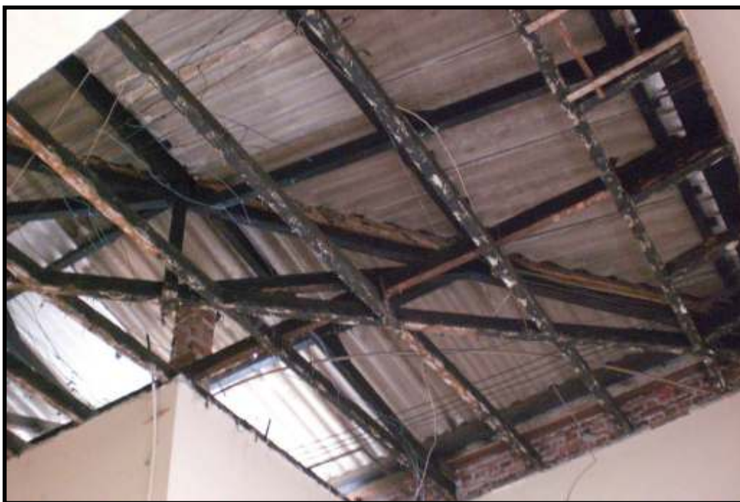
Reforma do telhado da Estação de Morretes-PR. Foto: Cid Turatti.
