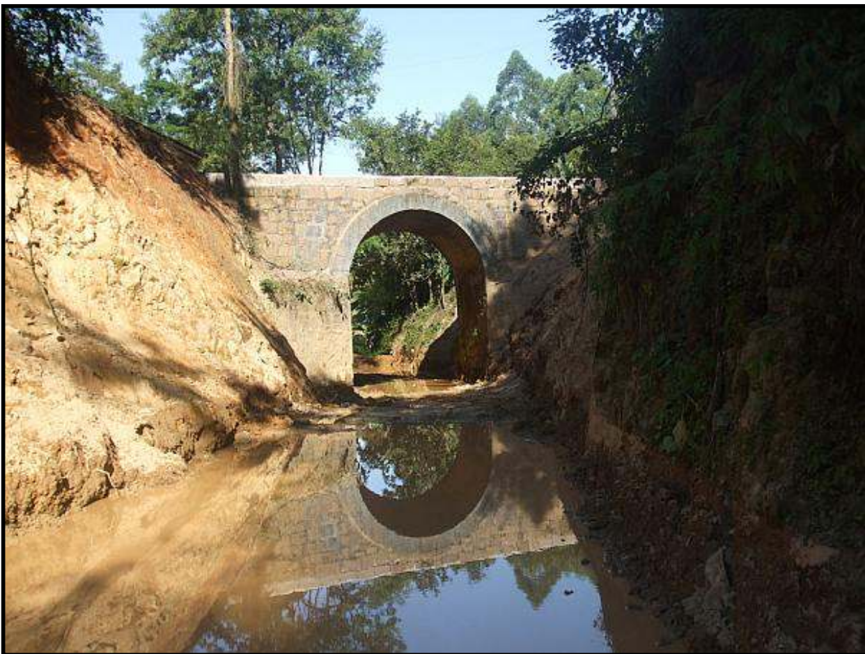
Construída entre os anos de 1924 e 1925, a passagem superior em arco já teve a parte superior restaurada e agora passará por processo de limpeza. Foto: Luiz Carlos Henkels em 28 de março de 2009.
