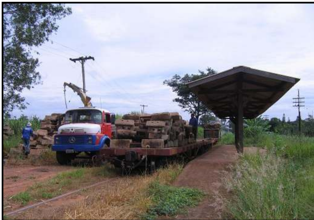
Transbordo dos dormentes de concreto doados pela FCA-VALE para trem de via permanente encarregado de distribuí-los ao longo da via. Foto: Hélio Gazetta Filho em março de 2009.
