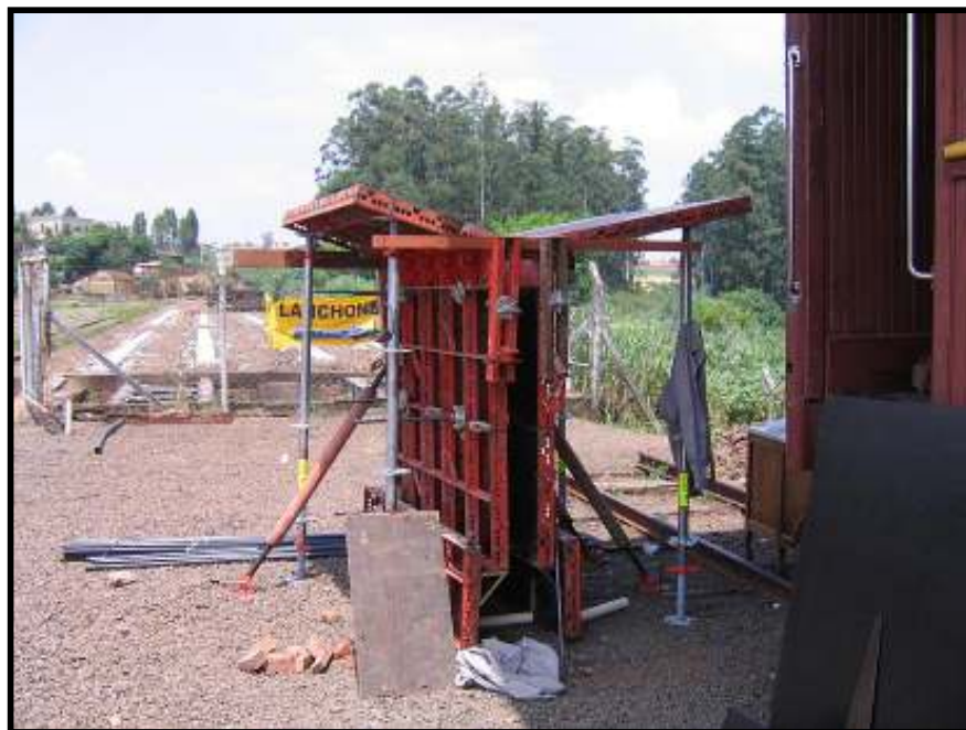
Moldes utilizados na construção das longarinas da extensão da linha de Anhumas à praça Arautos da Paz em Campinas-SP. Foto: Hélio Gazetta Filho em março de 2009.
