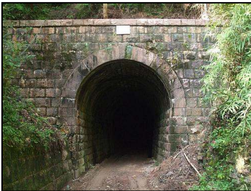
O Túnel Subida foi construído entre 1923 e 1924 e possui 80m de extensão, em curva. Faz parte dos três quilômetros pretendidos para reativação patrocinados pelo CESAP. Ao final de abril o engenheiro Evânio Lopes providenciou a desobstrução dos canais de drenagem, limpeza parcial e correção de algumas infiltrações. Foto: Luiz Carlos Henkels
