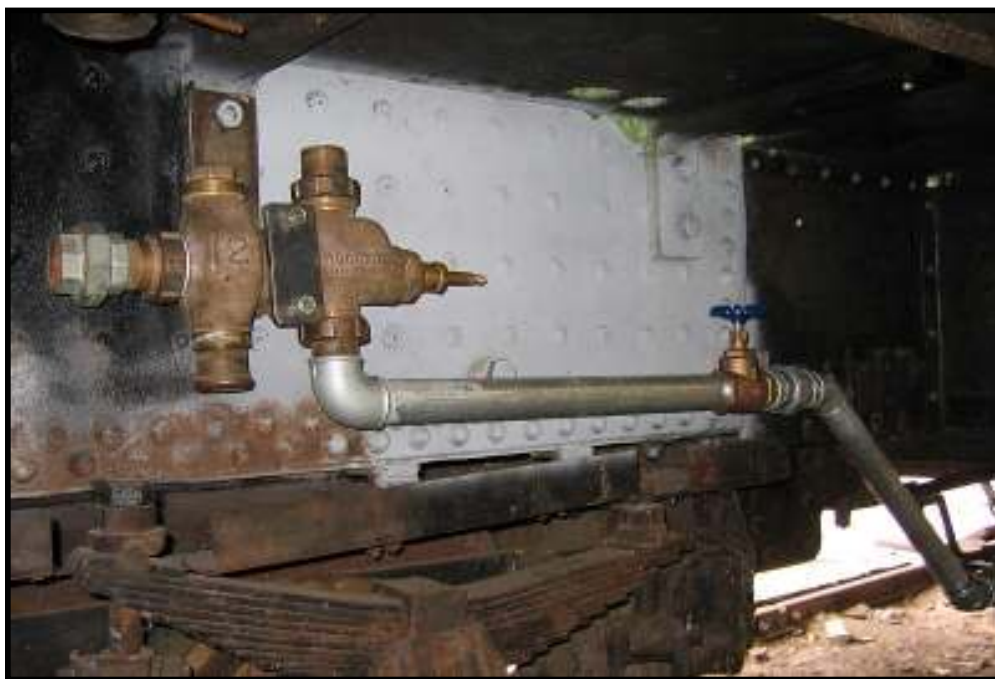
Novo injetor para locomotiva a vapor n. 401 já instalado. Foto: Hélio Gazetta Filho em maio de 2009.
