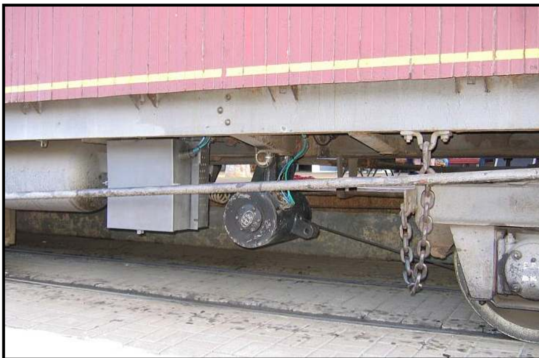
Carro CR-17 com gerador e novo regulador de voltagem (desenvolvido pelo Sr. João Sigris) já instalados. Foto: Hélio Gazetta Filho em maio de 2009.
