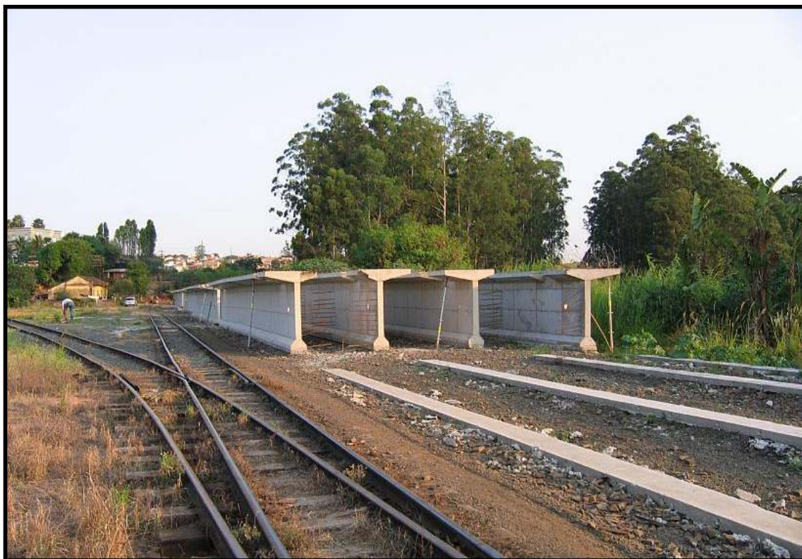
Longarinas que serão utilizadas na extensão da linha até a praça Arautos da Paz em Campinas-SP.
