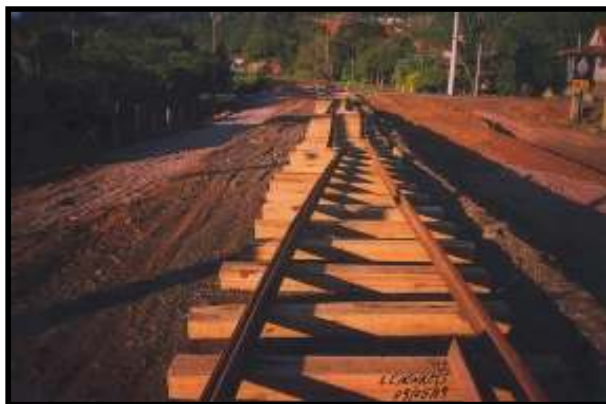
Aspecto do início da construção da via férrea na direção de Lontras-SC, saindo do pátio da estação. Foto: Luiz Carlos Henkels em 9/05/2009.
