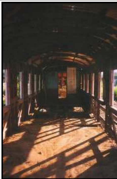
Carro P 02 em início de obras de restauração com retirada da madeira apodrecida. Foto: Luiz Carlos Henkels em 9/05/2009.
