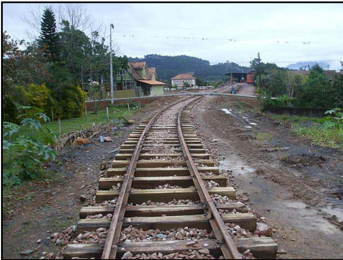
Novo trecho de linha assentado nas proximidades da estação de Matador em Rio do Sul-SC. Até recentemente, a linha terminava pouco antes da passagem de nível que aparece na foto. A estação de Matador aparece ao fundo e à direita na foto. Foto: Luiz Carlos Henkels em 6/07/2009.
