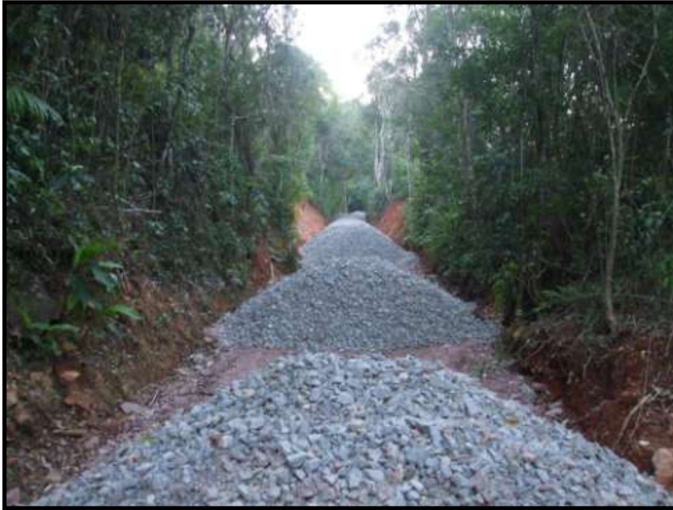
Imensa quantidade de brita, fornecida pelo CESAP, já está disponibilizada para ser distribuída ao longo do leito em Subida.
