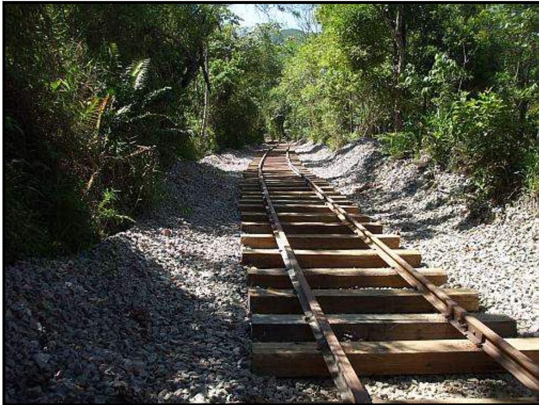
Trecho com via férrea instalada aguardando nivelção em Subida.
