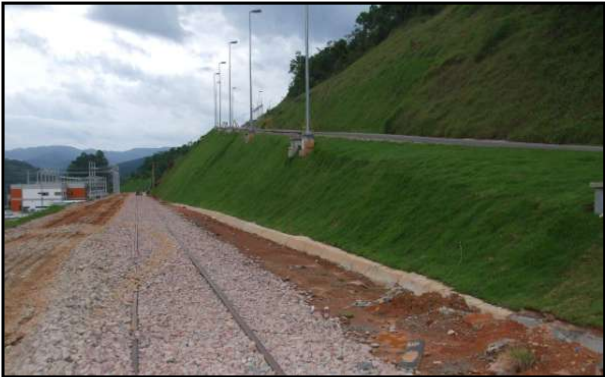
Próximo ao "final da linha" de 3,5 km, aspecto da via férrea passando em meio a Usina Salto Pilão, pronta para receber a "soca" e a nivelção definitiva, obra que está sendo feita por empreiteira especializada. Foto: Luiz Carlos Henkels em 28/11/2009.
