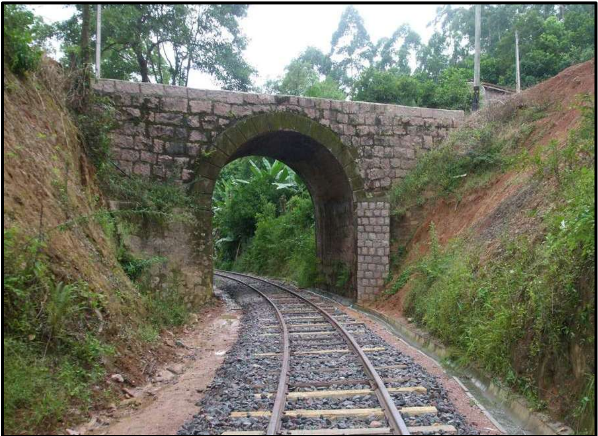
Linha concluída sob a passagem superior de Subida. Foto: Luiz Carlos Henkels em 13/01/2010.
