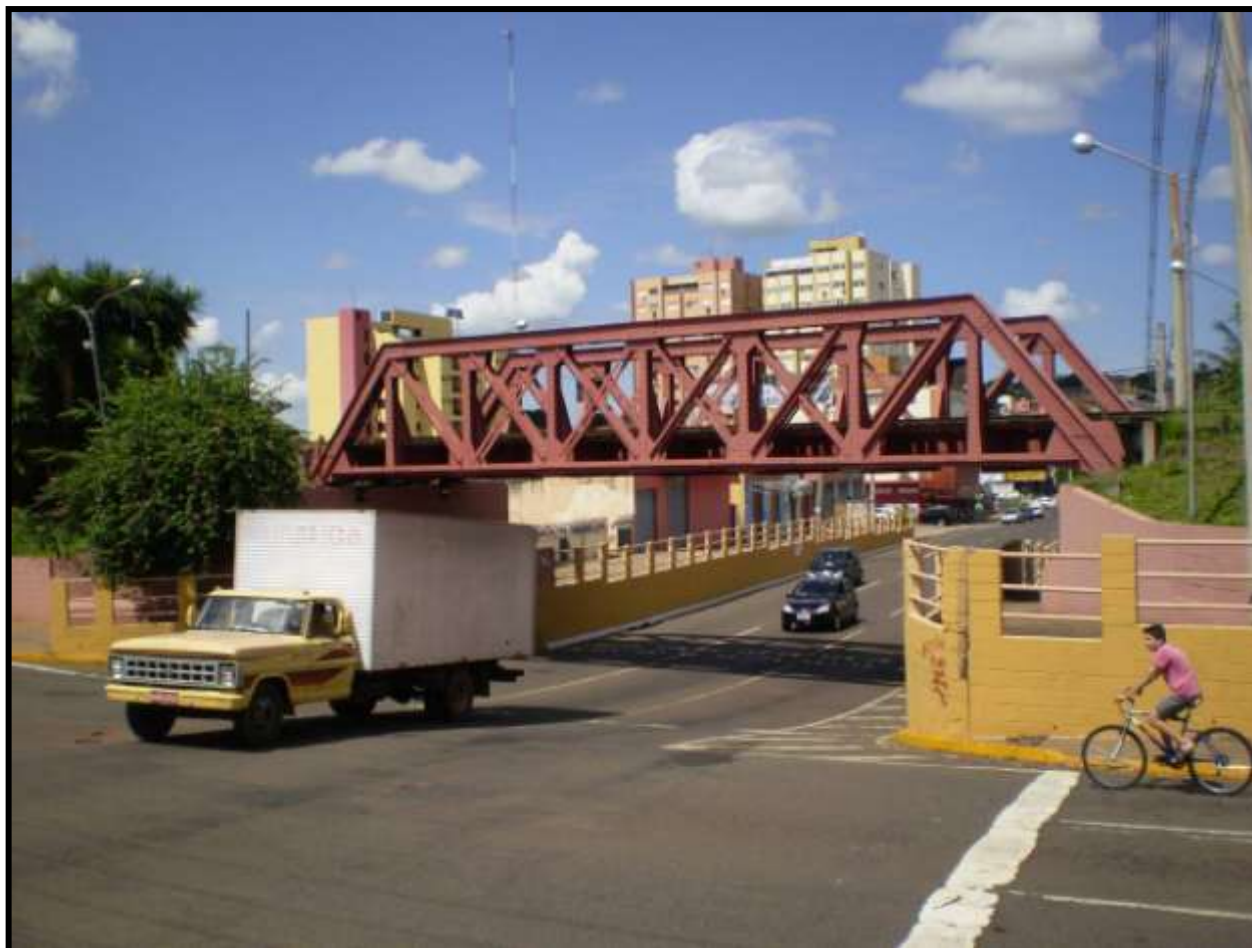
Viaduto próximo a estação de Campo Grande-MS.
