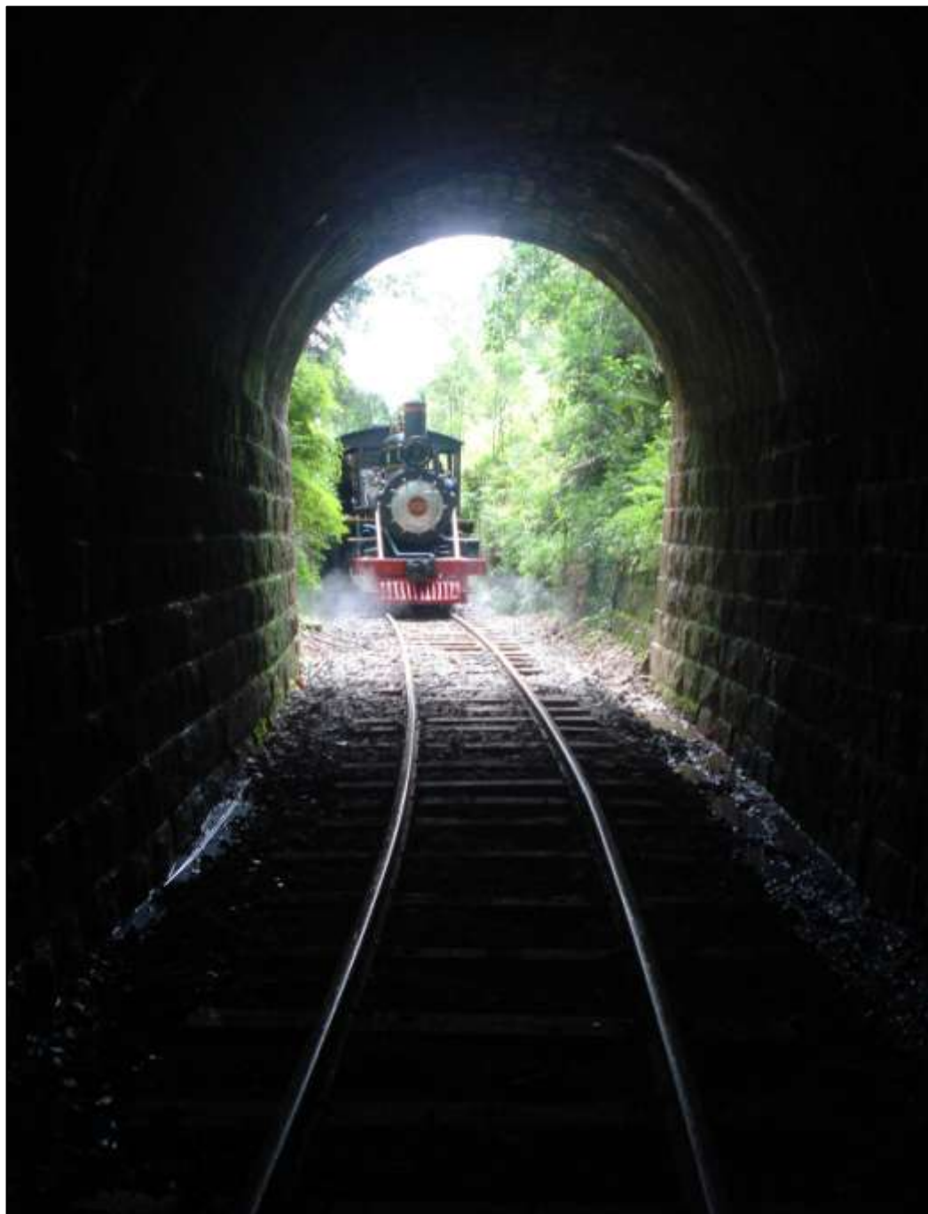
Locomotiva 232 e composição em testes de linha no túnel Subida, após 38 anos e 11 meses sem passar trem por este local. Foto: Charles Thurow em fevereiro de 2010.
